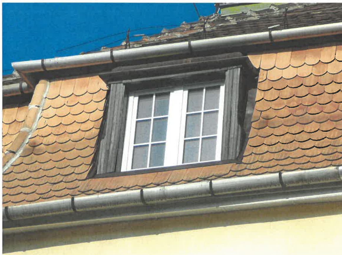
A törtvonalú új tetőablaksáv és az eredeti tetőablakok (új műanyag ablakokkal)
