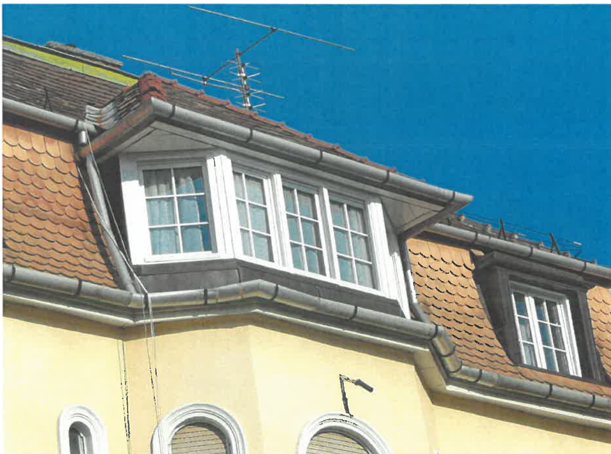
A törtvonalú új tetőablaksáv és az eredeti tetőablakok (új műanyag ablakokkal)
