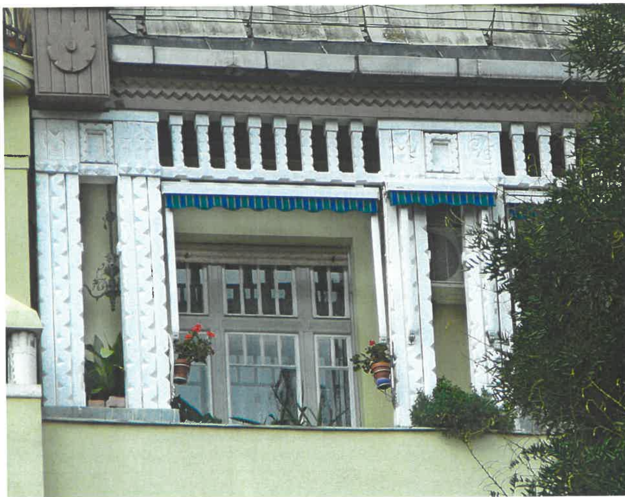
A tető alatt a jobboldalon hosszú erkély, amely érdekes fa tartószerkezettel kapcsolódik a széles ereszhez; ez a markáns motívum fehérre van festve, pedig sötét (barna/zöld) szín illene hozzá; a szép kompozíció a korszak jellegzetes népies, a magyaros szecesszió irányzatához tartozó falfaragását idézi
