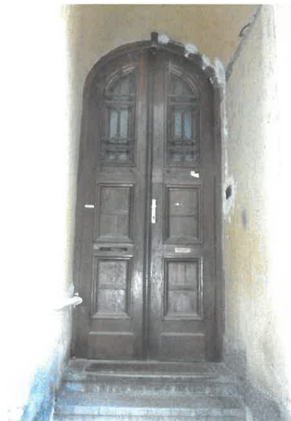
Az ablakból átalakított lakás-bejárati ajtó a ház bal oldalán
