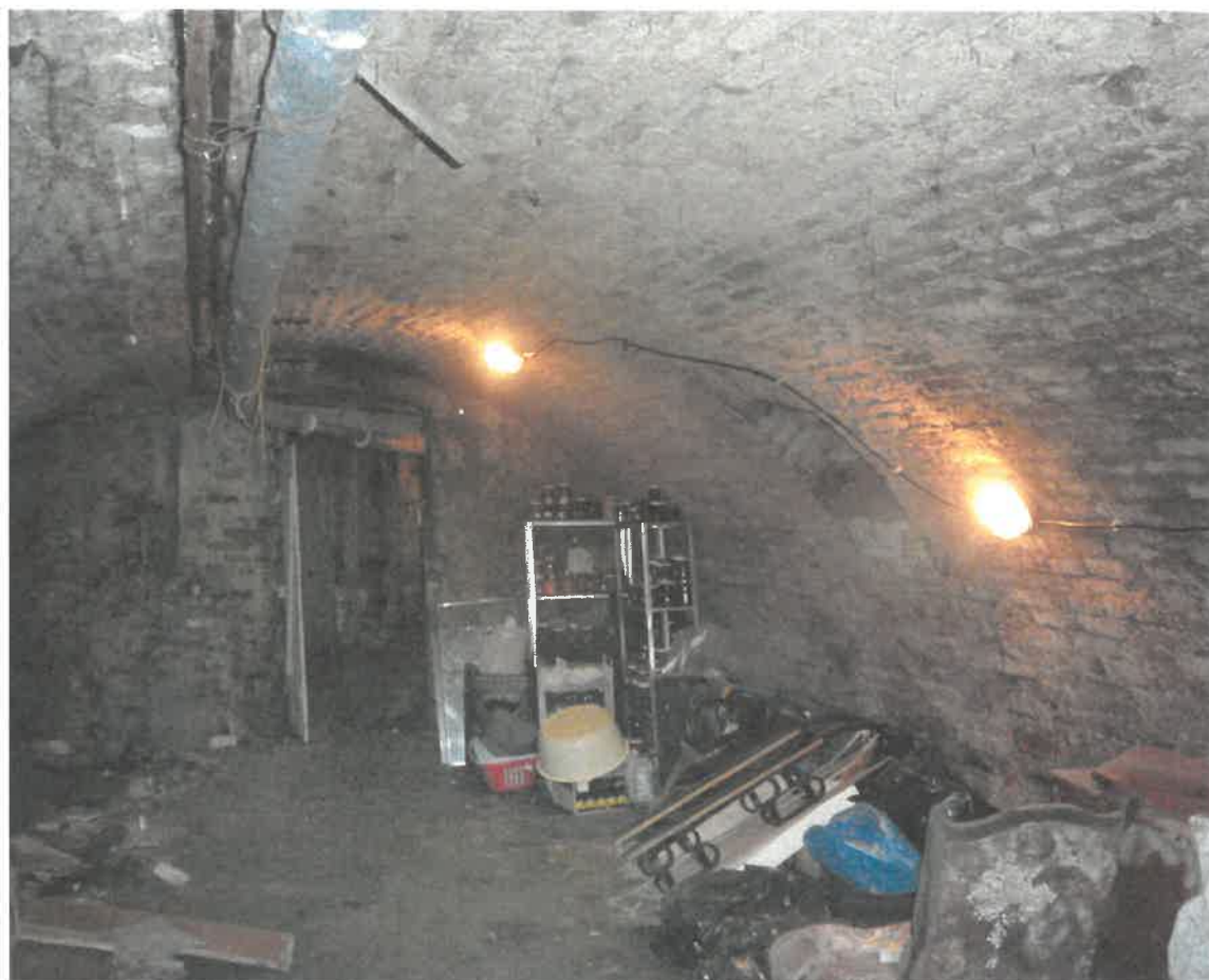
Az eredeti földszintes épület téglalobozatos pincéje
