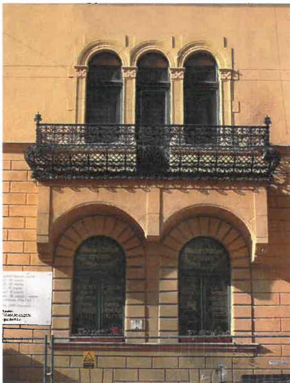
A ház szimmetriatengelyében, az erkély alatti kettős boltív közepéről hiányzik a kőszerkezetet mutató konzol
