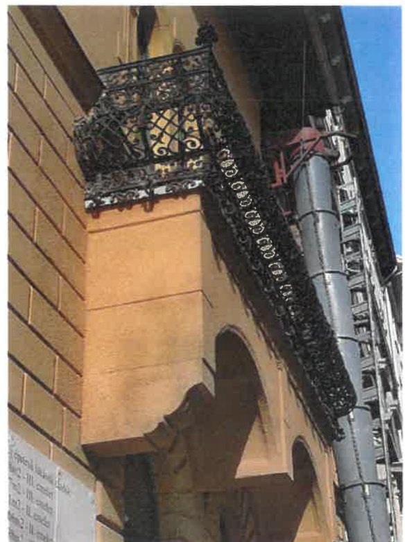
A ház szimmetriatengelyében, az erkély alatti kettős boltív közepéről hiányzik a kőszerkezetet mutató konzol
