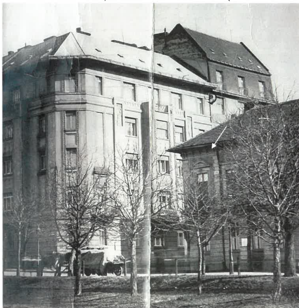
1936-os felvétel a Pauler u. Mikó u. sarkáról a Vérmező felől (forrás: Fővárosi Levéltár): jól látható a Pauler u. 22. sz. épületen az emeleti erkélyajtó fölötti, ma már hiányzó szegmensívű timpanon, a konzolokkal díszített zárópárkány és a földszint eredeti, kváderezett kialakítása (ld. 11. old. archív terv)
