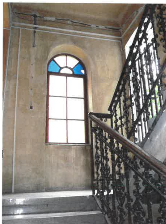
Tardosi vörösmárvány függőfolyosó-lemez, udvari pihenőknél színes üvegablak-maradvány
