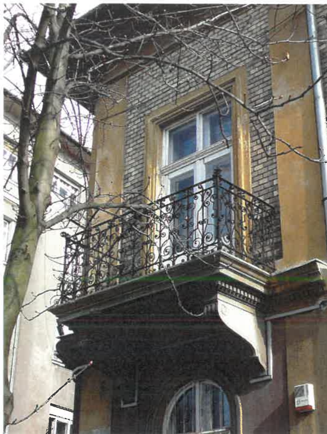
A Vérmező felé néző faragott kőkonzolos, az osztópárkánnyal azonos profilú kőlemez es erkélyek kovácsoltvas ráccsal
