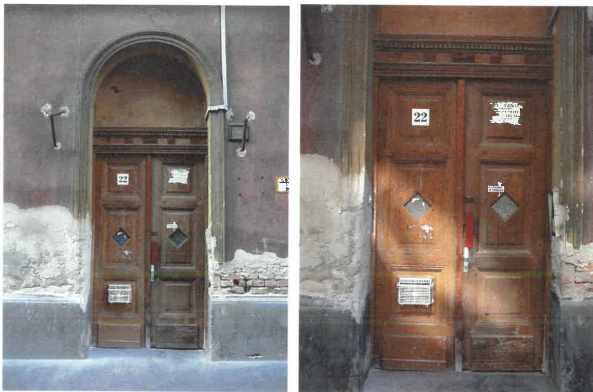
Széles tokosztó párkánnyal díszített eredeti fakapu a Pauler utcában, felülvilágító farostlemezrel lezárva, megnyitása utcaképi és épülethasználati szempontból is indokolt
