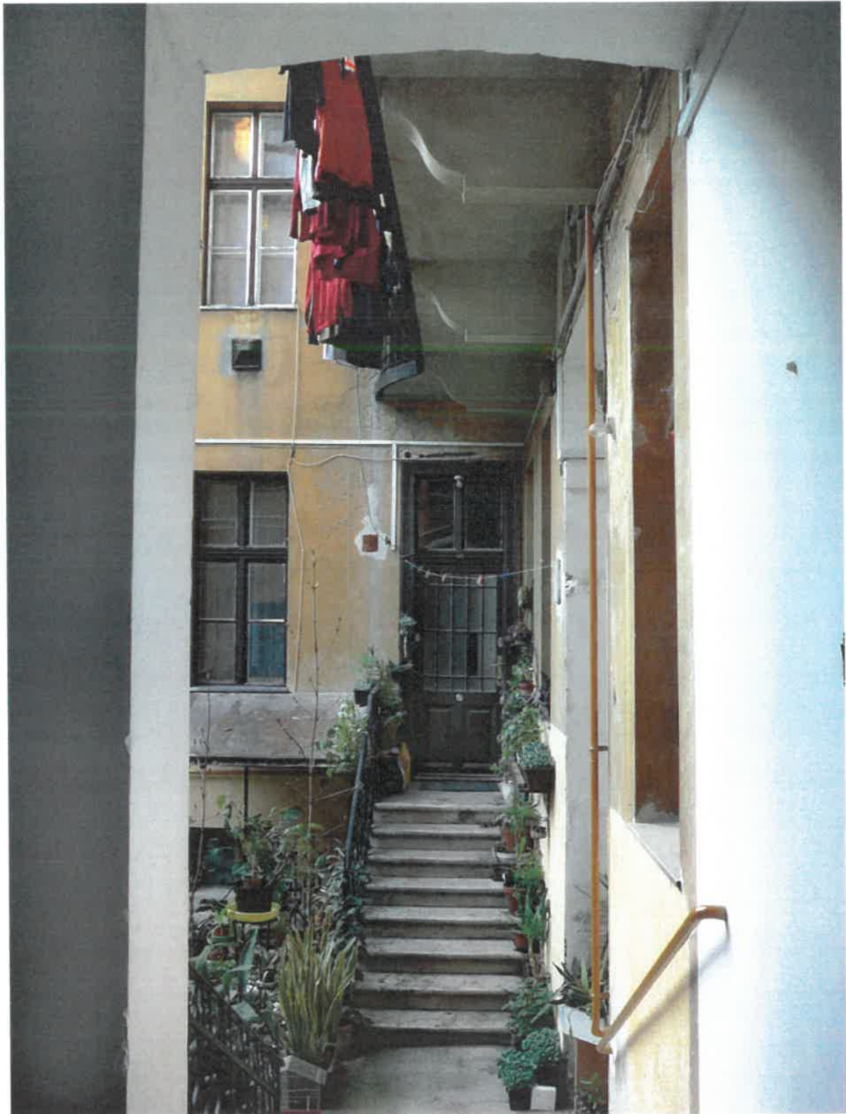
Udvarrészlet: eredeti ablakokkal, lépcsőfeljárókkal, javított függőfolyosó-kőkonzollokkal
