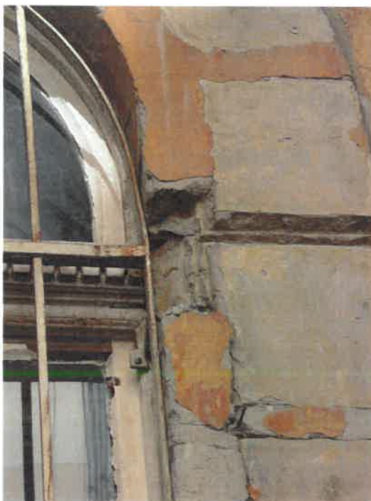
Az eredeti architektúra szakszerű helyreállítása falkutatást igényel
