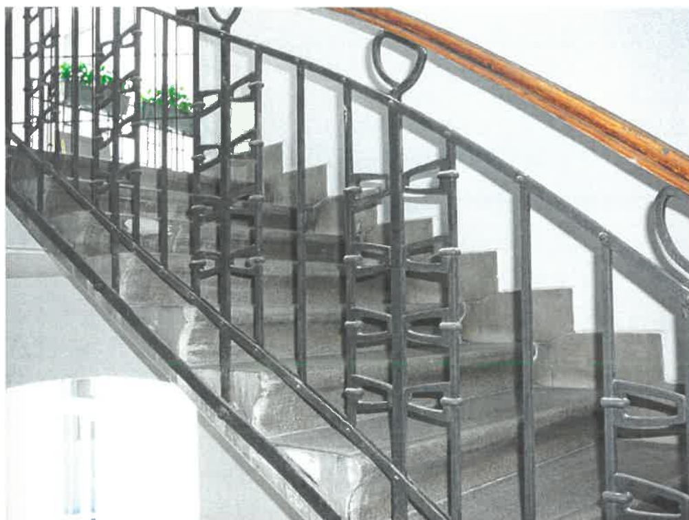
Egyszerűségében elegáns és rendkívül eredeti a „masni“-motívumú szegecselt korlát a lépcsőházban a profilos fa kézfogóval!
