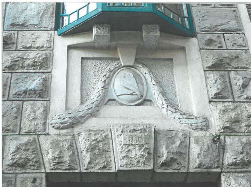
A magasföldszint kétoldali ablakainak köténydíszé: a lépcsősen mélyített tükörben ovális keretbe foglalt madarat formázó plasztika - zárókő-motívumos füzérdíszszel
