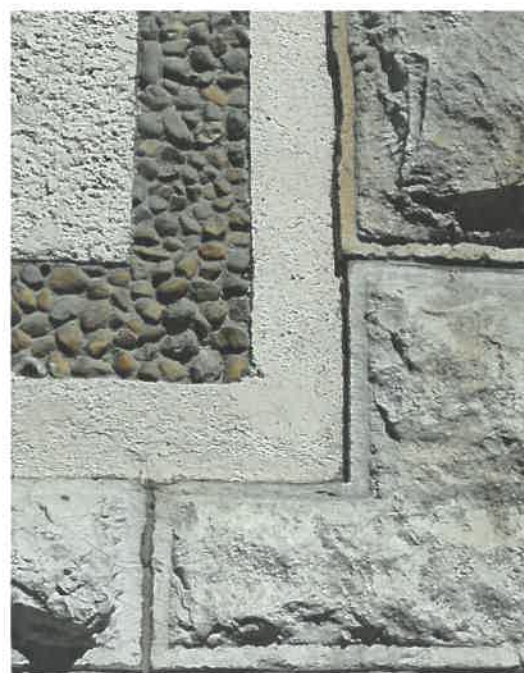
A földszinti és a magasföldszinti szinteket összekötő rusztikus kőburkolat-sávok közötti vakolt falmezők díszé az érdekes kavicsberakásos keret
