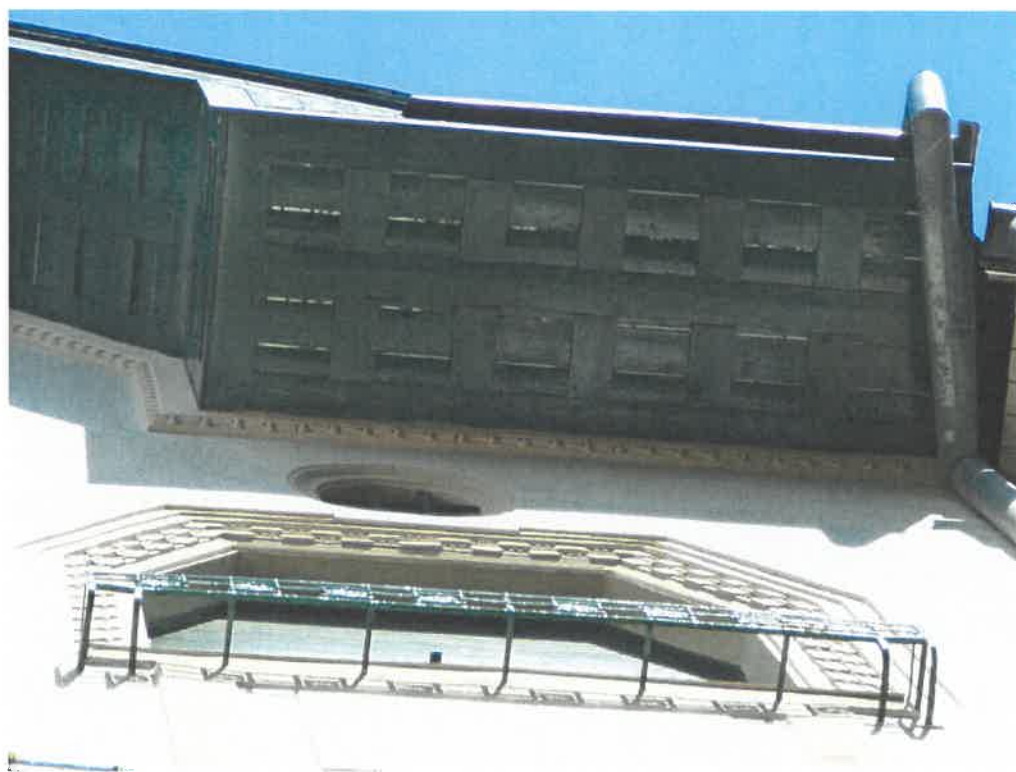
A förtvonalú, erőteljes tetőoromzat, melynek széles faeresze kazettás kialakítású, a falcsatlakozásoknál plasztikus gipsz-dísz-sávval
