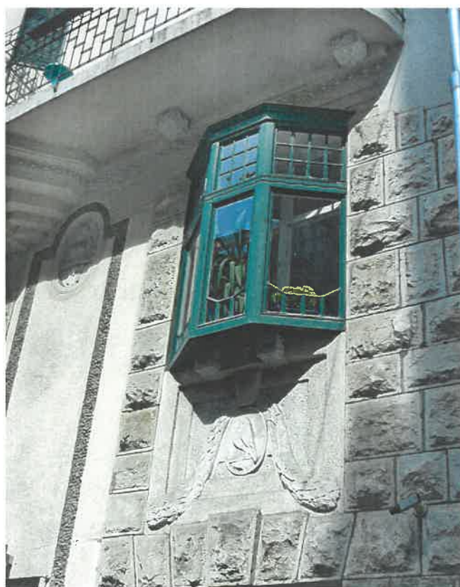
A földszinti és a magasföldszinti szinteket összekötő rusztikus kőburkolat-sávok közötti vakolt falmezők díszé az érdekes kavicsberakásos keret
