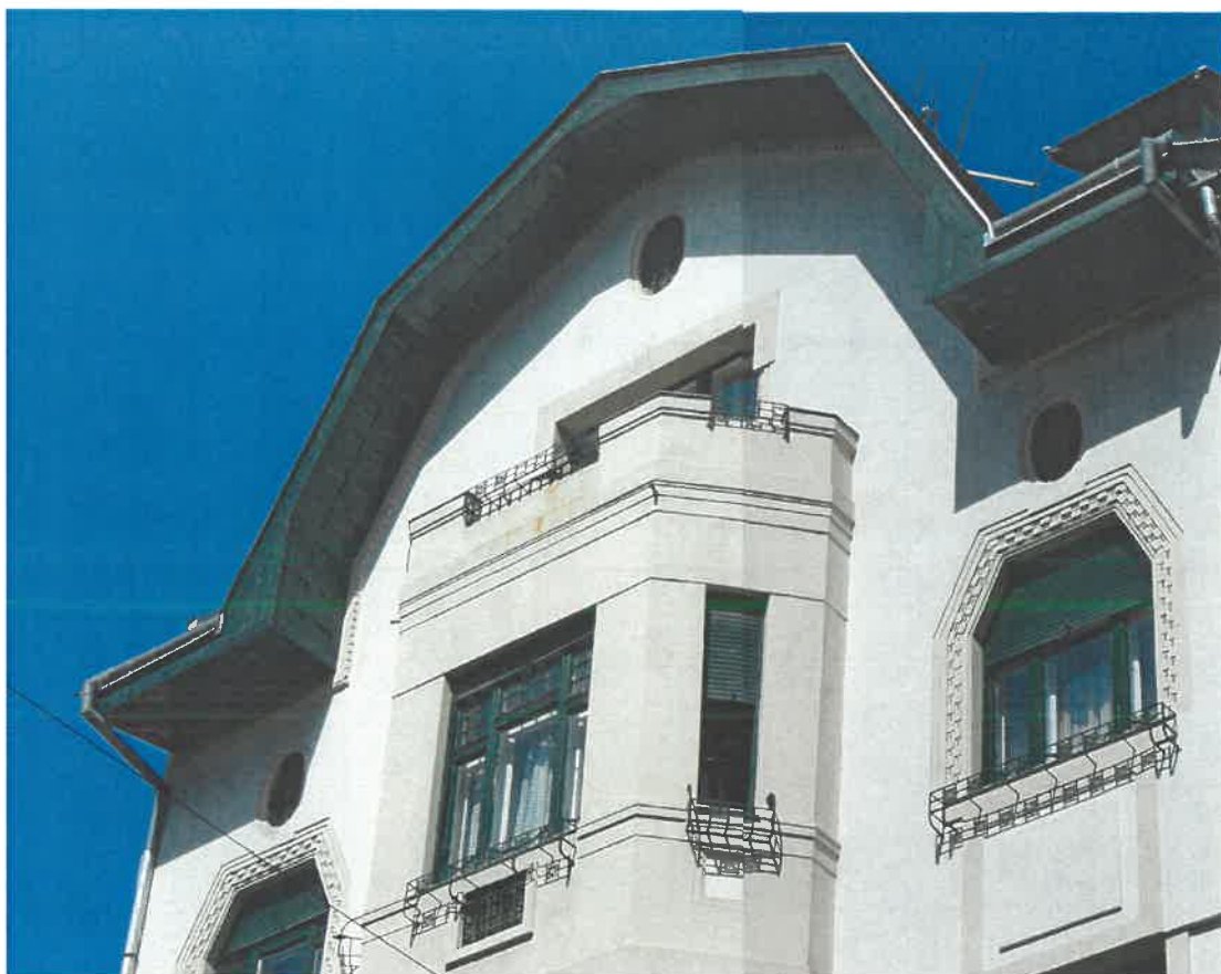
A förtvonalú, erőteljes tetőoromzat, melynek széles faeresze kazettás kialakítású, a falcsatlakozásoknál plasztikus gipsz-dísz-sávval
