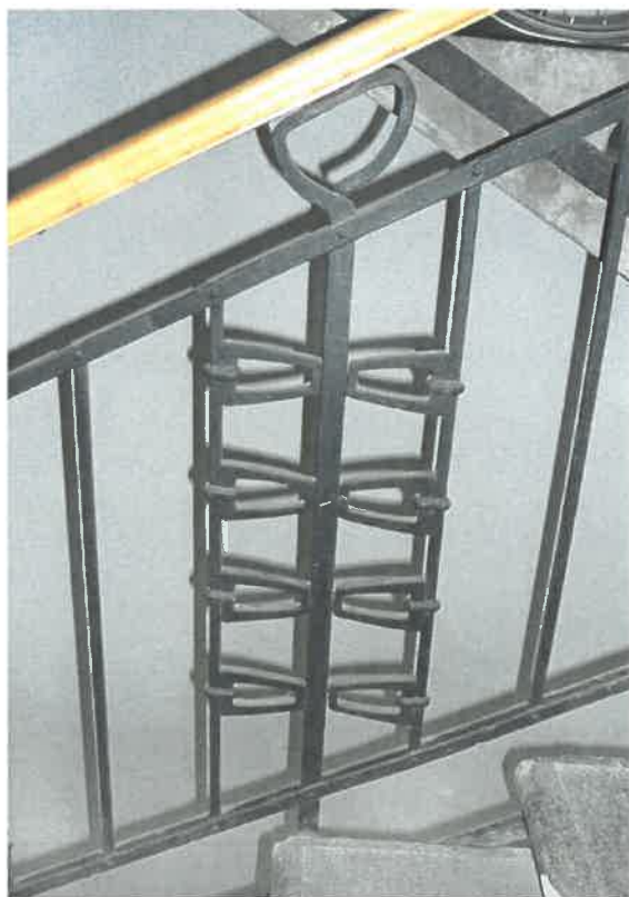
Egyszerűségében elegáns és rendkívül eredeti a „masni“-motívumú szegecselt korlát a lépcsőházban a profilos fa kézfogóval!
