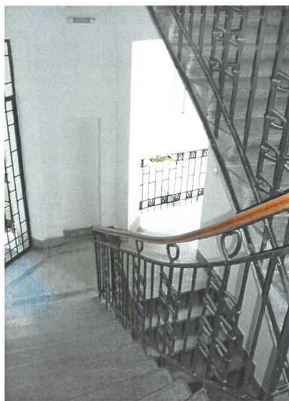
Egyszerűségében elegáns és rendkívül eredeti a „masni“-motívumú szegecselt korlát a lépcsőházban a profilos fa kézfogóval!
