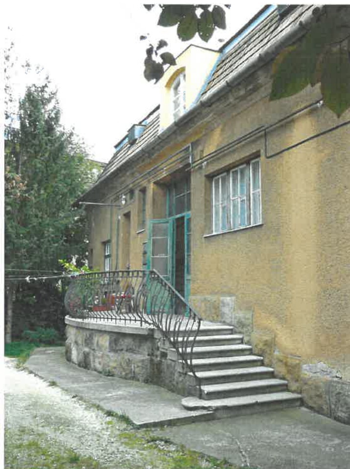
A hátsó (északnyugati) homlokzat az utólag beüvegezett fedett-nyitott „ácsorgóval” (eredeti formájában megmaradt a terasz, a bal oldali ablak és ajtó (v. cselédbejáró))
