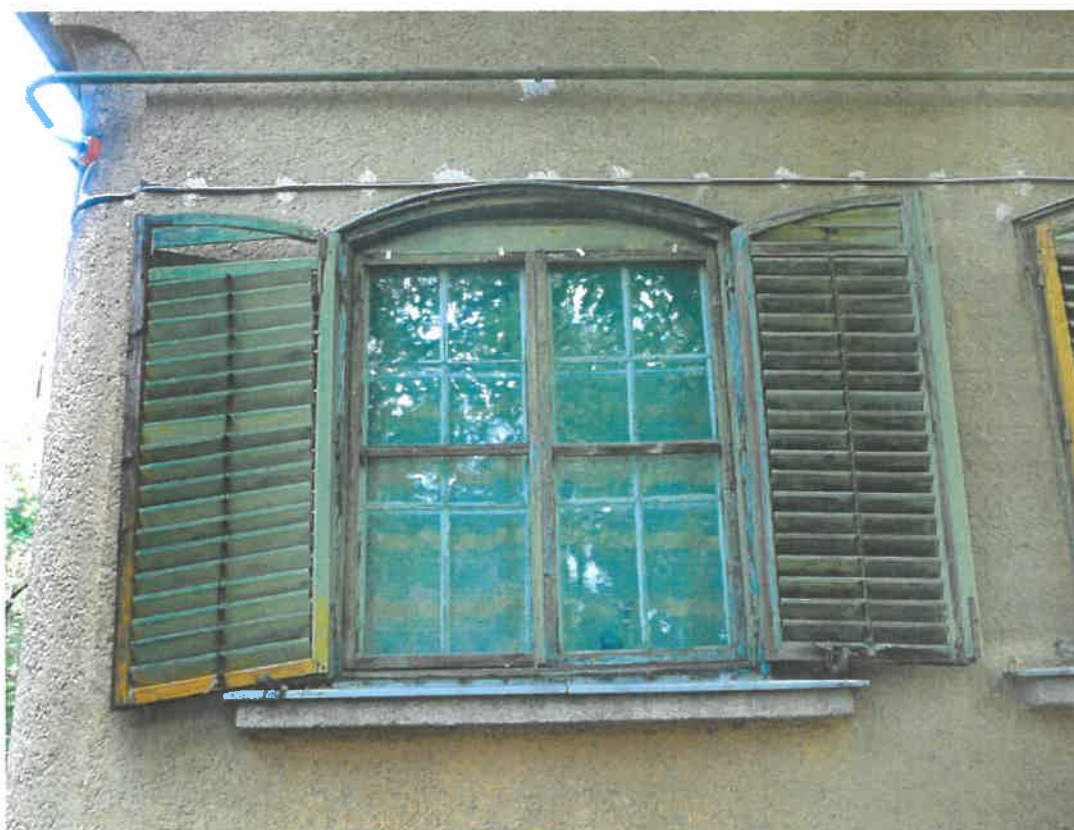
A zsalus ablakok egykori díszítő vakolatkeretelésére az ablakok alatt hosszan túlnyúló könyöklőpárkányok ma is utalnak
