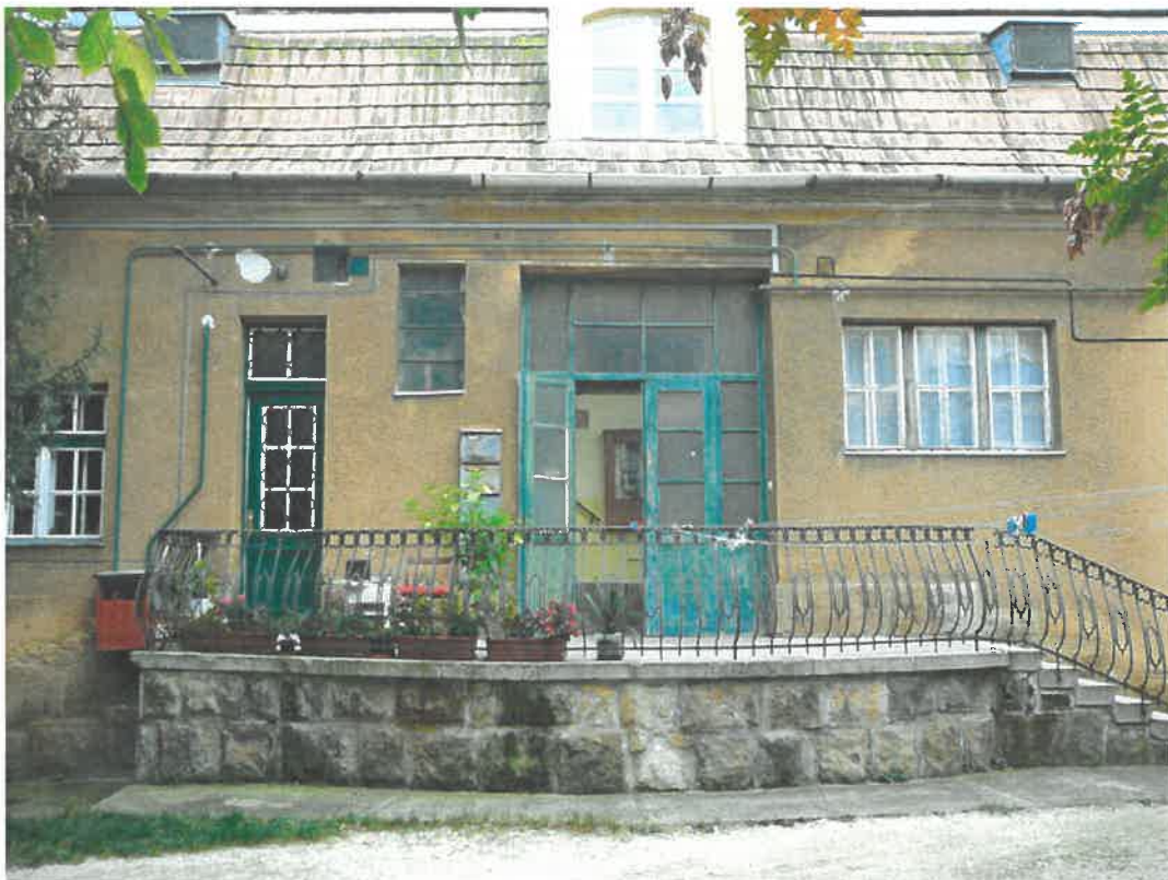
A hátsó (északnyugati) homlokzat az utólag beüvegezett fedett-nyitott „ácsorgóval” (eredeti formájában megmaradt a terasz, a bal oldali ablak és ajtó (v. cselédbejáró))
