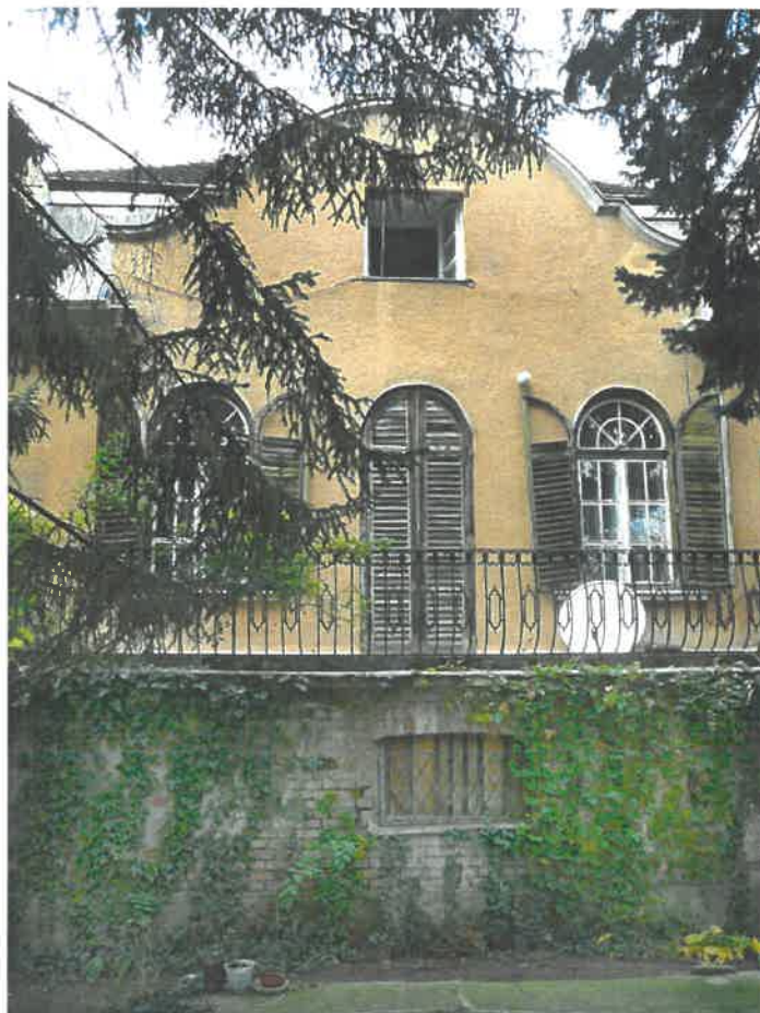
A főhomlokzat a hiányzó ablakkeretelésekkel, az utólagosan beépített tetőtérrel
