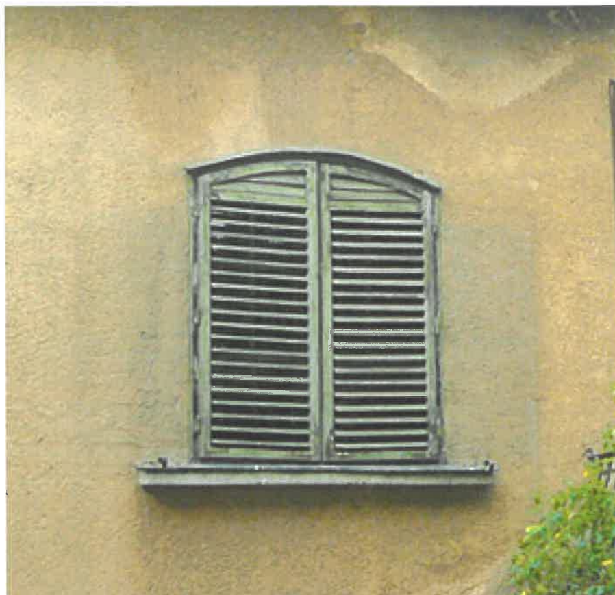
A zsalus ablakok egykori díszítő vakolatkeretelésére az ablakok alatt hosszan túlnyúló könyöklőpárkányok ma is utalnak
