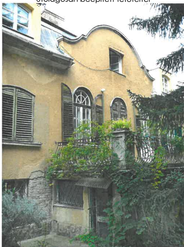
A főhomlokzat a hiányzó ablakkeretelésekkel, az utólagosan beépített tetőtérrel
