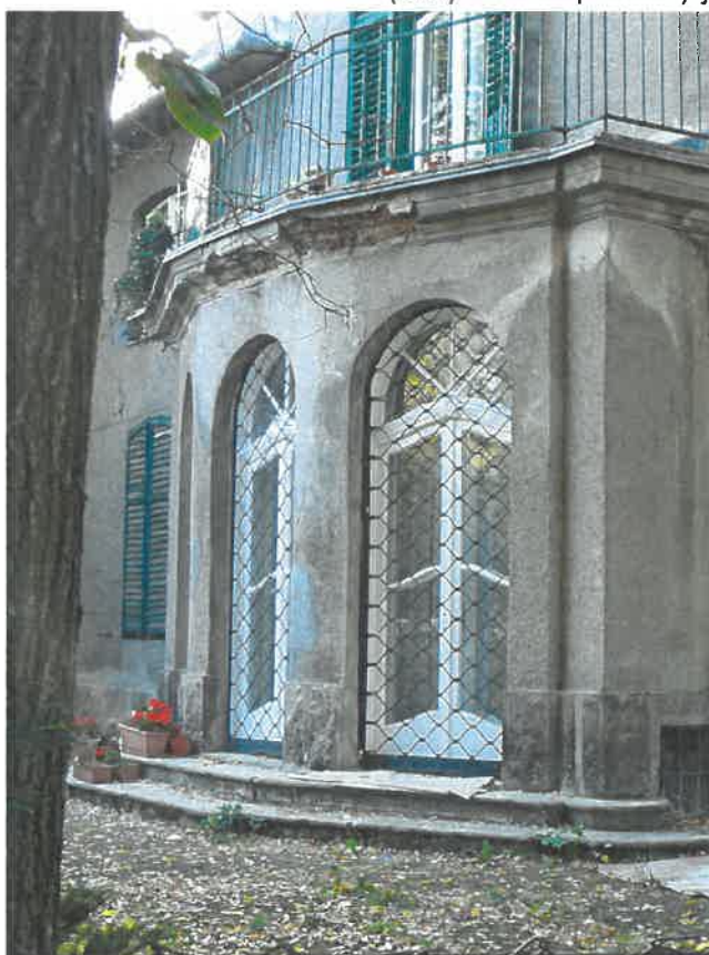
Az előrelépő földszinti íves rizalit a műkö előlépcsőkkel és (alul) a teraszpárkány javításra szoruló hibái
