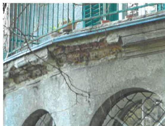
Az előrelépő földszinti íves rizalit a műkö előlépcsőkkel és (alul) a teraszpárkány javításra szoruló hibái
