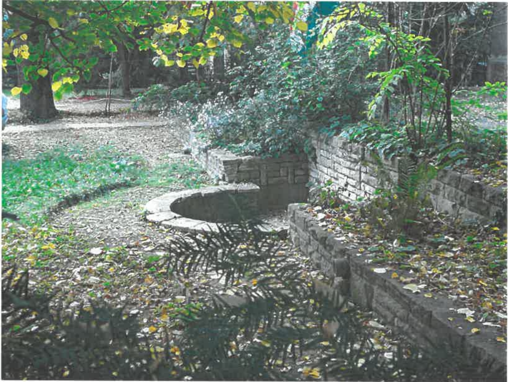
A szimmetrikus elrendezésű kert kompozíciós értékű díszje a kis félköríves vízmedence az alacsony, márgával támasztott tereplépcsők alatt
