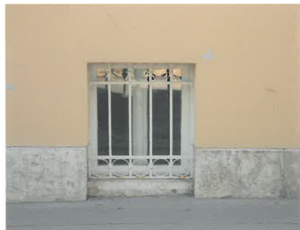
utcai homlokzat, alagsori ablakrács
