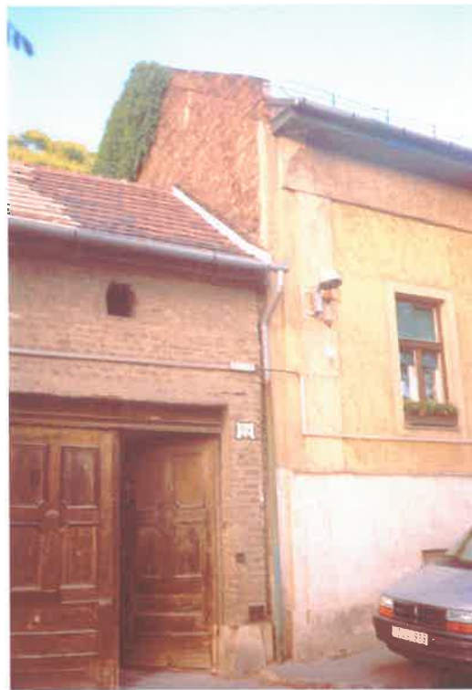
az utcai homlokzat részletei, 1999
