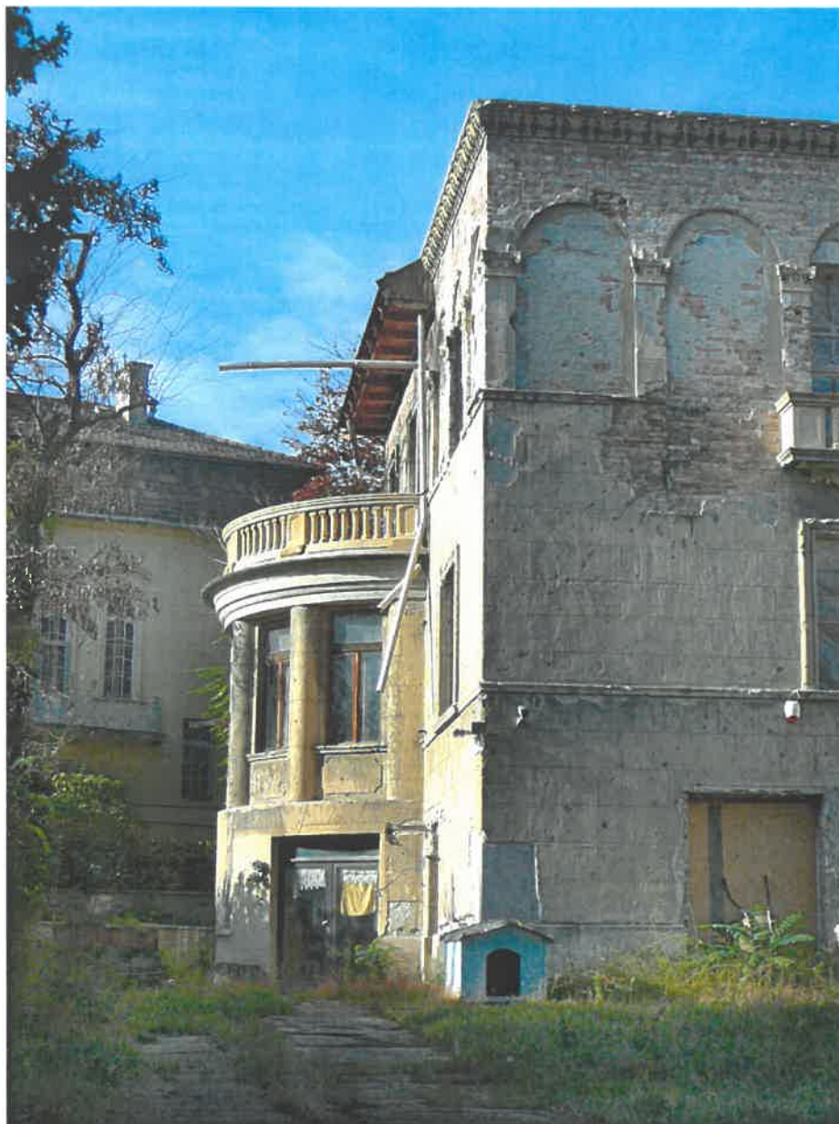
A bal oldali homlokzat nagy kétszintes hengeres ívén az ablakok között oszloptörzs-szerű tagolások, felette magas párkány, majd törpeoszlopokkal díszített teraszmellvéd
