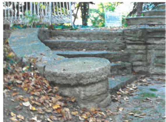
A földszinti lakás terepszintű teraszához vezető kőlépcsők alacsony márga-falacskák között, ill., íves faragott alacsony kőtámfallal
