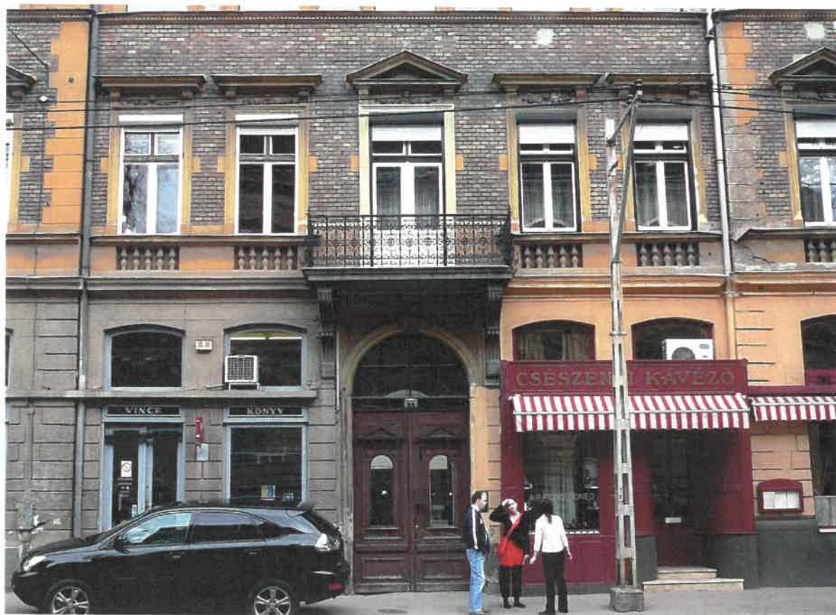
Téglaburkolatú, timpanonos és szemöldökös ablakpárkányokkal felépített szimmetrikus szerkesztésű homlokzat két oldalán sarokrizzalittal
