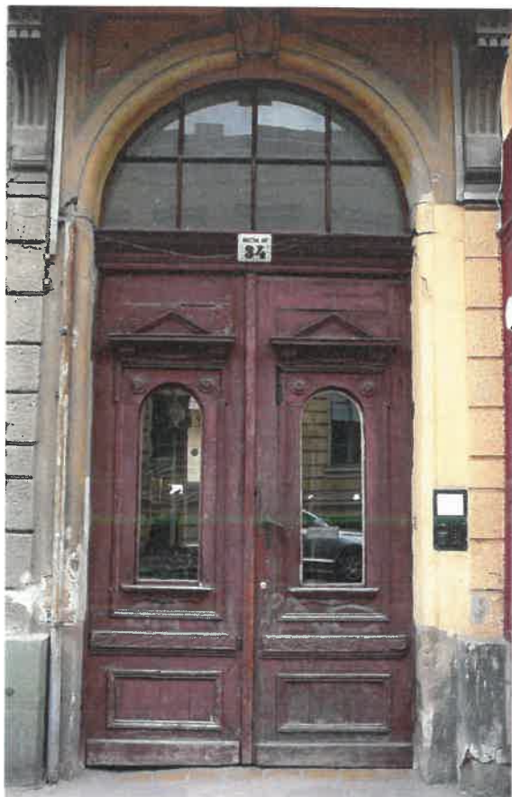
Eredeti tölgyfakapu, a „csupasz” ablakok fölött a homlokzati ablakkeretelés formájára utaló timpanonos párkánymotívummal, részben hiányos díszítéssel, felújítható állapotban
