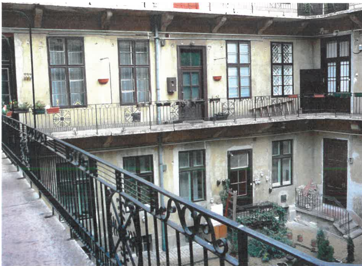
Feltűnően nagyméretű ki-benyíló udvari ablakok(!), rangos, klasszicizmus-kori osztásrenddel (alul/felül 3/2 arányban osztva), tordasi vörösmészke függőfolyosó-lemez, konzolok
