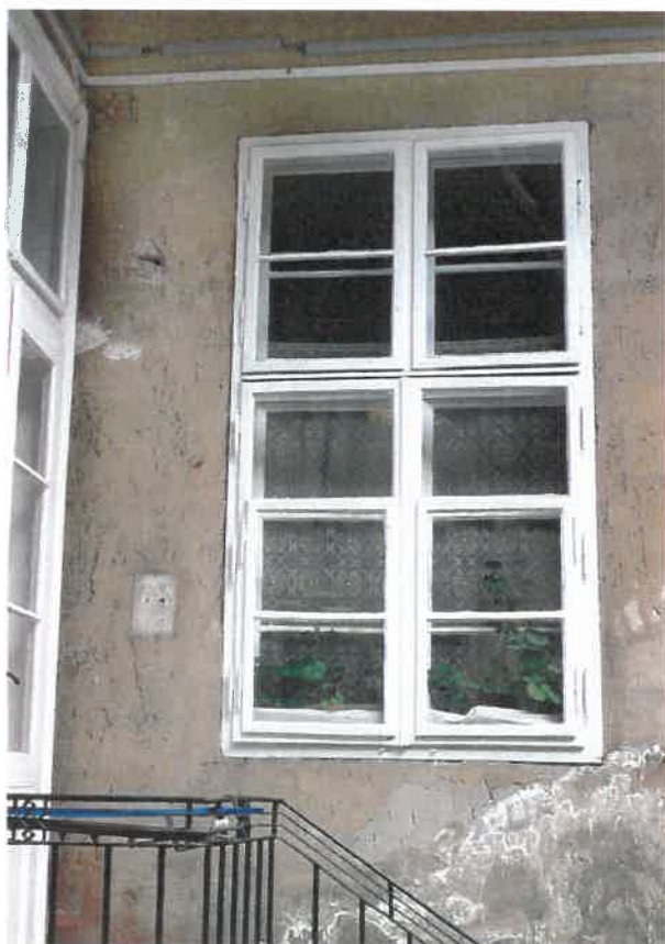
Feltűnően nagyméretű ki-benyíló udvari ablakok(!), rangos, klasszicizmus-kori osztásrenddel (alul/felül 3/2 arányban osztva), tordasi vörösmészke függőfolyosó-lemez, konzolok
