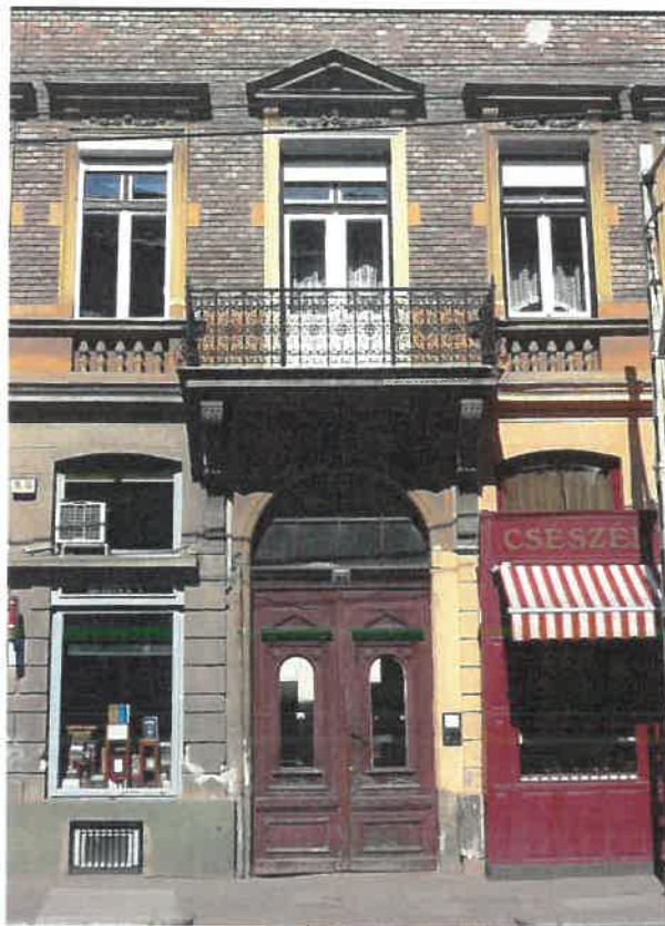
A baluszteres kötényekkel gazdagított széles osztópárkány közepén rostélyszerű ráccsal díszített, rangos, hosszított kőkonzolokon nyugvó erkély
