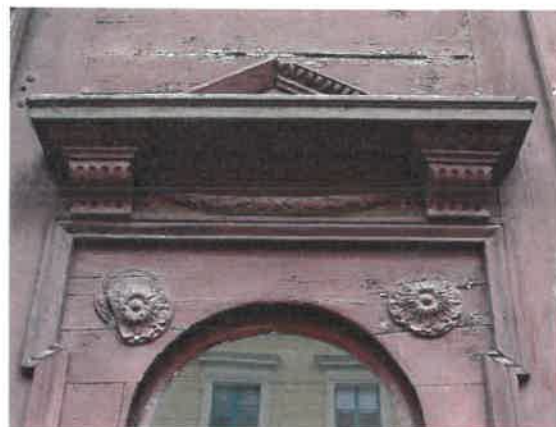
Eredeti tölgyfakapu, a „csupasz” ablakok fölött a homlokzati ablakkeretelés formájára utaló timpanonos párkánymotívummal, részben hiányos díszítéssel, felújítható állapotban
