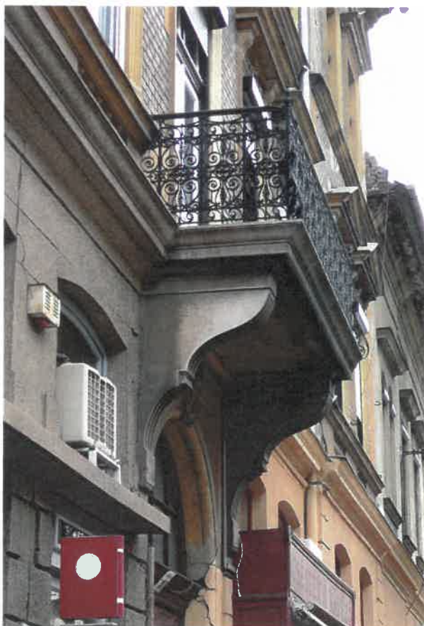
A baluszteres kötényekkel gazdagított széles osztópárkány közepén rostélyszerű ráccsal díszített, rangos, hosszított kőkonzolokon nyugvó erkély
