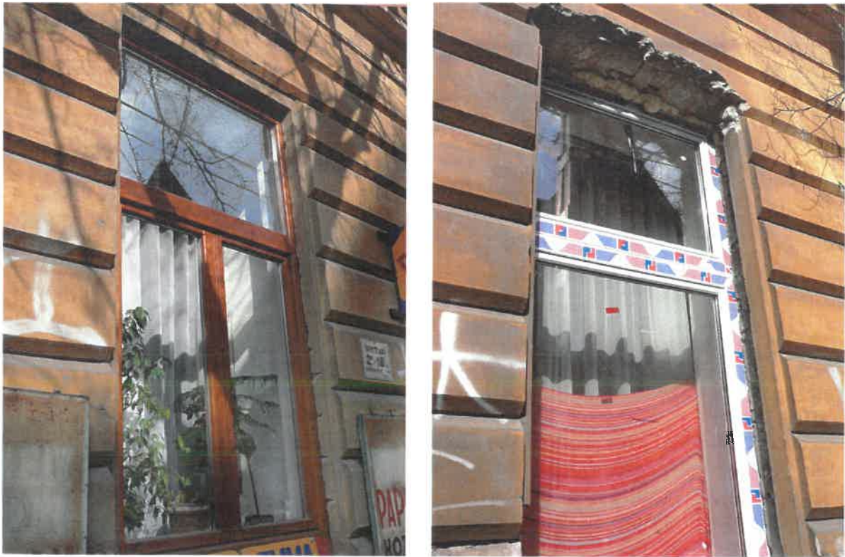
Ablakcserek a földszinten; a széles műanyag-keretű(!), fehér(!) ablakok alkalmazása méltatlan az egységesen fennmaradt régi értékes épülethez!
