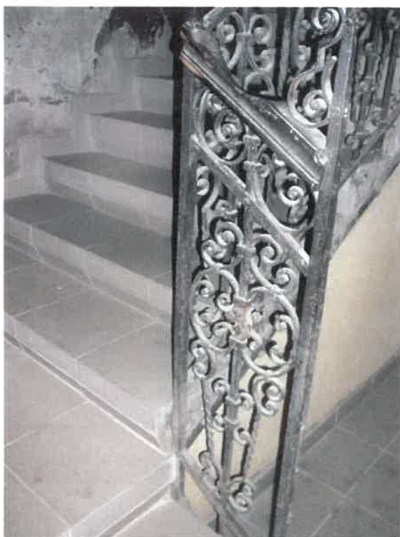
A kapu belső oldala (nagykapuban gyalogkapu), szép kovácsoltvas díszrács a betekintőablakokon, terrazzo-burkolat, gazdag díszítésű kovácsoltvas lépcsőkoriátok
