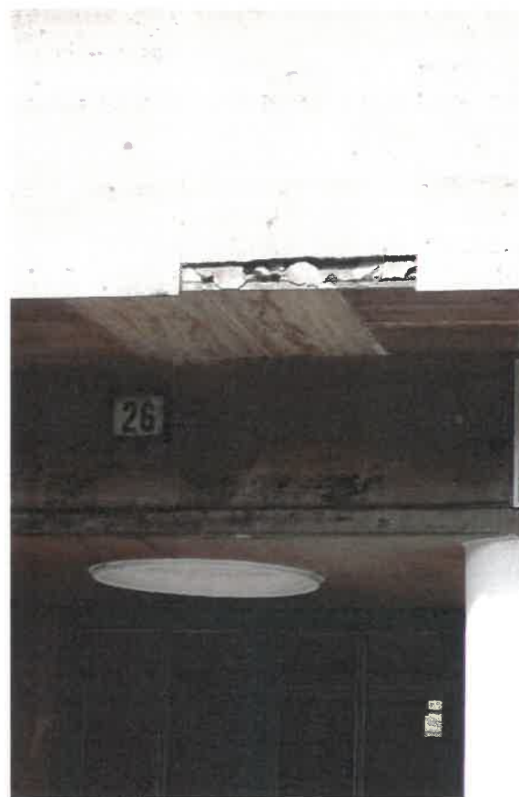
Egy-egy helyen a homlokzati travertin- kőburkolat sérülései javításra szorulnak
