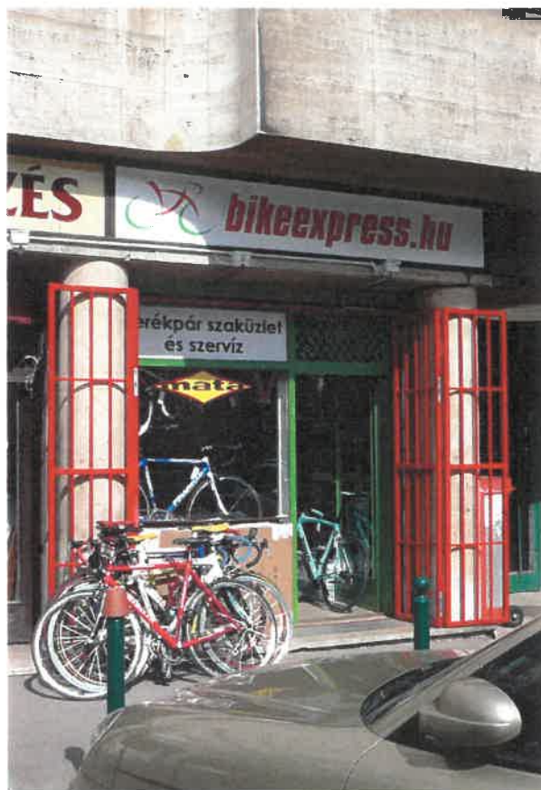
Zavaró az oszlopot takaró piros védőrács; javaslat: a biztonsági berendezés belső, üzlet-tér-felőli kialakítása
