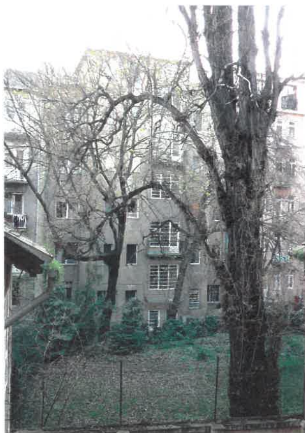
Az udvari homlokzat a lépcsőház-bevilágító osztott óriásablakkal
