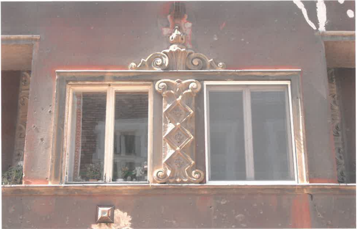
homlokzati díszek az I. emeleti zárterkélyen, a parapet-konvektorok védőrácsaival
