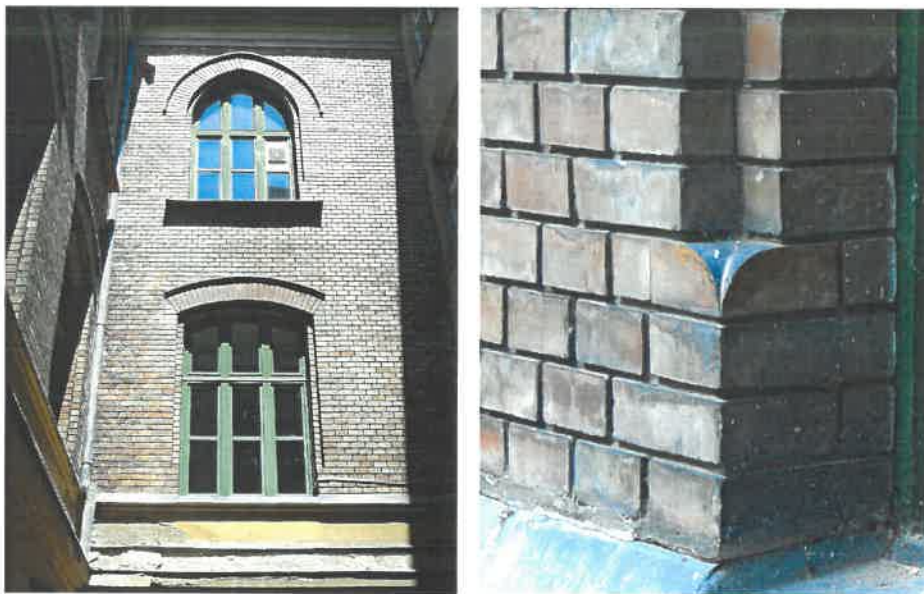
Az utca felőli szűk, zárt udvar igényes (építéskor közterületről is látszó) homlokzatképzése
