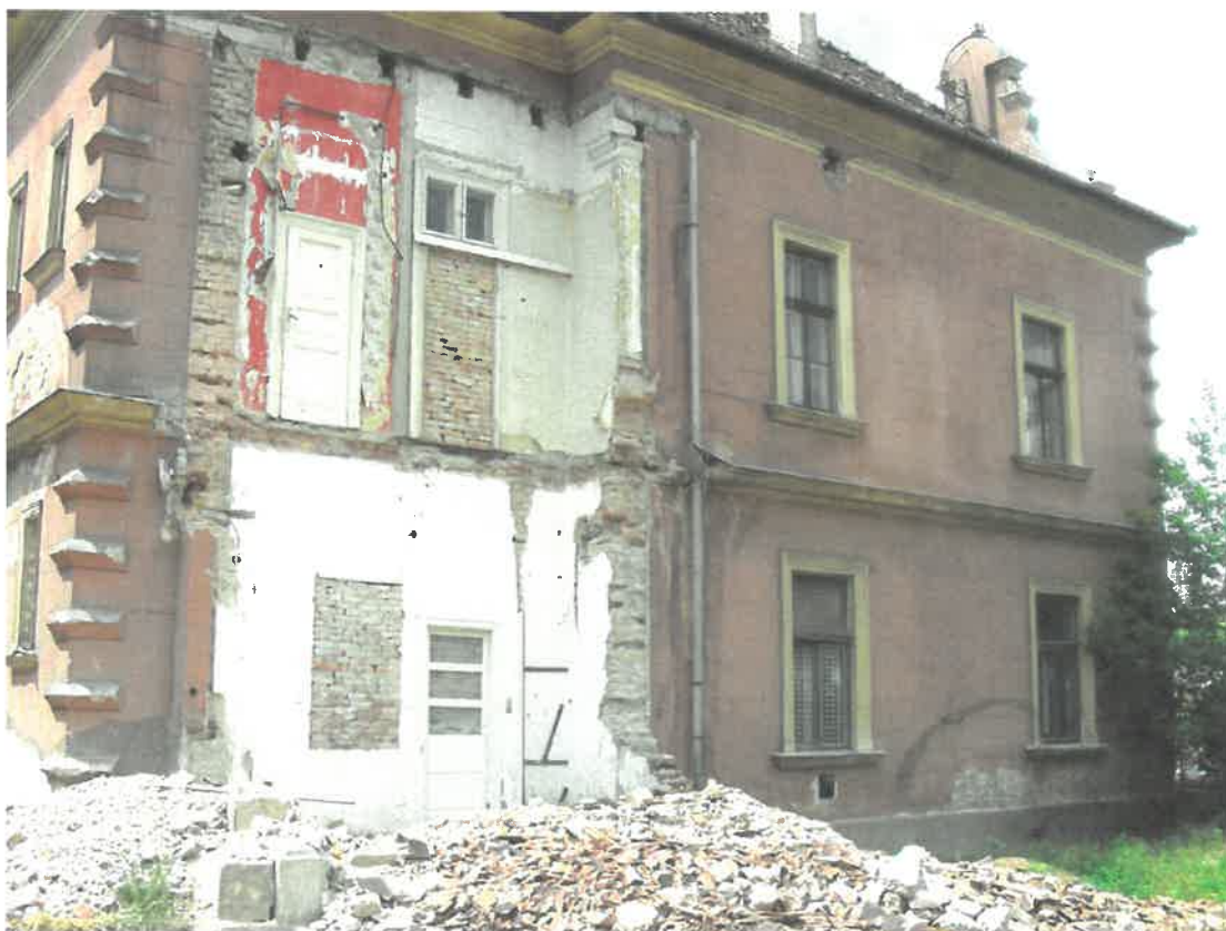
A bal oldali (keleti) homlokzat a lebontott emeletes toldalék-rész helyével
