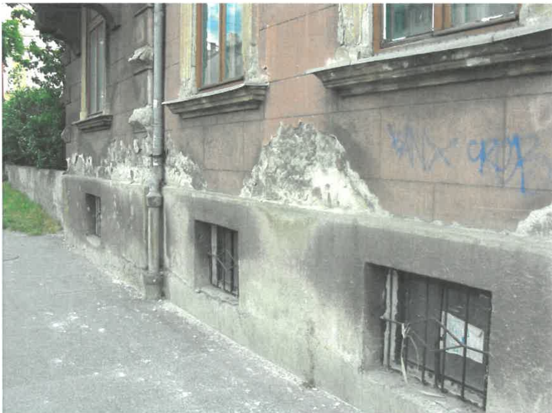
A jobb oldali (nyugati) homlokzat a lábazat felett lefagyott vakolat javításával (felső kép)
