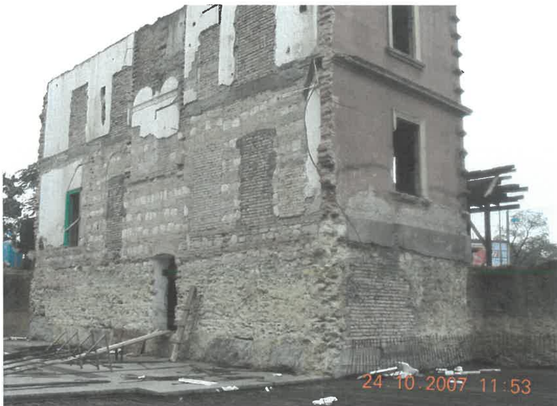
A ház még álló utcai traktusa hátulról; jól látható egy korábbi épület (ld. 14. old.) vegyes kőfalának és a pincszinti márgafalnak a felhasználása az épületben
