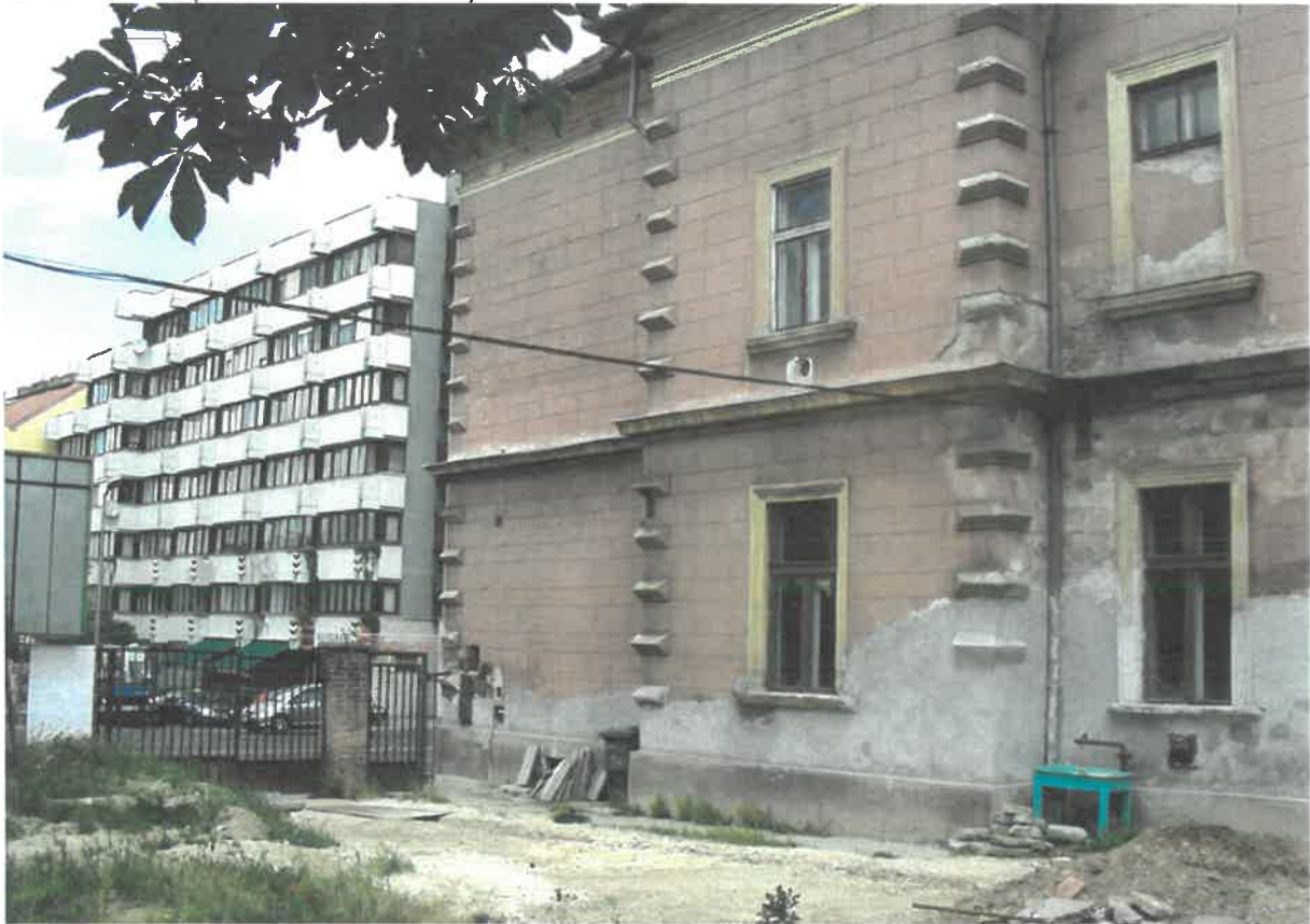
A jobb oldali (nyugati) homlokzat a lábazat felett lefagyott vakolat javításával (felső kép)
