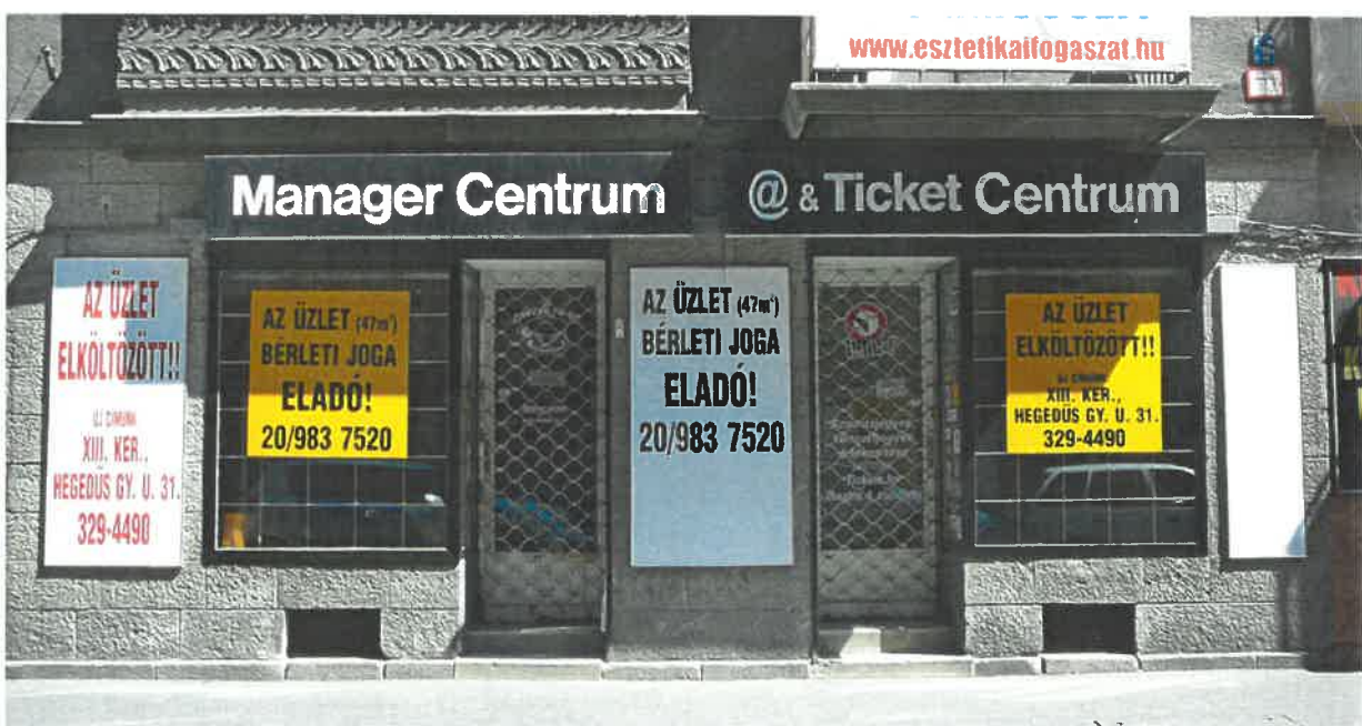
Hatalmas reklámtáblákkal takart a földszinti homlokzat kőburkolata az épület jobboldalán
