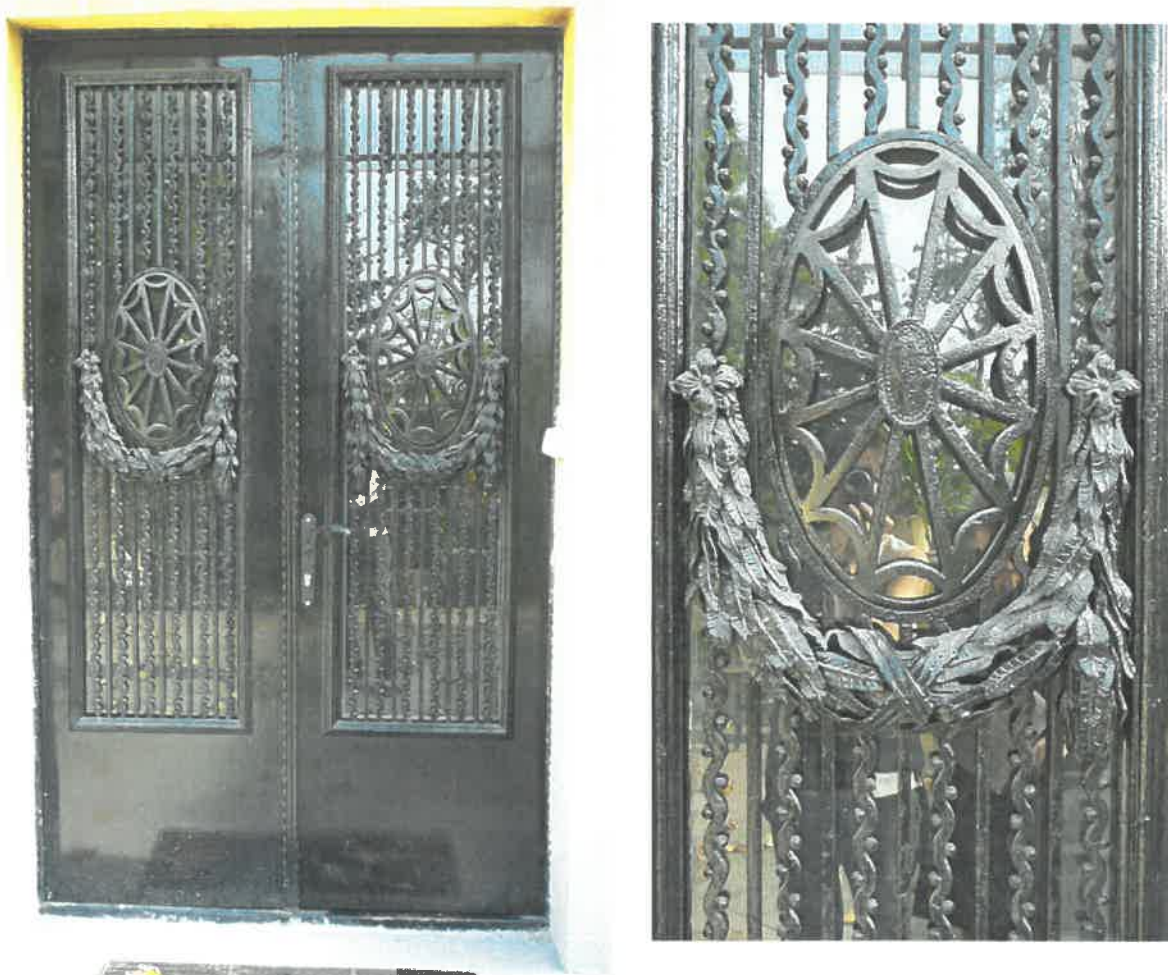
Posztsecessiós bejárati ajtó a kerti homlokzaton, szép kovácsoltvas rácsa copf motívumokkal gazdagon díszítve
