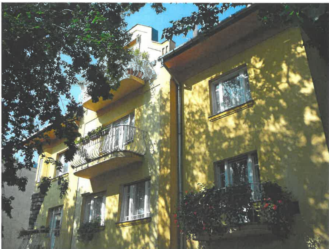
Az épület szimmetriatengelyében lévő oromfalas kiemelés az új (1993-ban épült) tetőtéri erkéllyel
