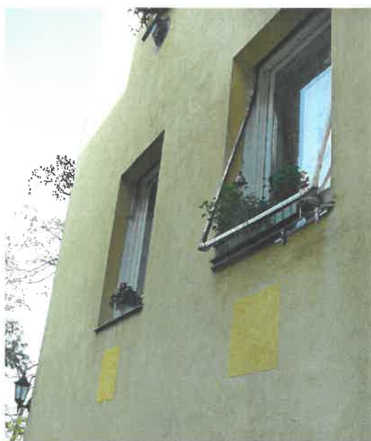
Az ún. „héra-fejek” leszerelése utáni homlokzathelyreállítás kulturált megoldása (a következő homlokzatfestésig) a délnyugati homlokzaton
