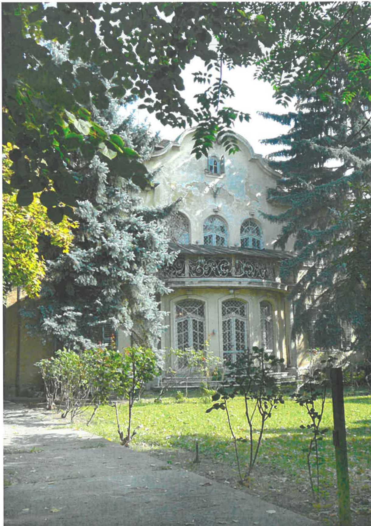
2008. A neobarokk villa utcai feltárulása ma a komoly, téralkotó faállomány lombkoronái között; az erkély lefedését a burkolat időjárás-okozta sérülései (fagyáskárok) tették szükségessé; gondozott kert, használaton kívülnek tűnő épület
