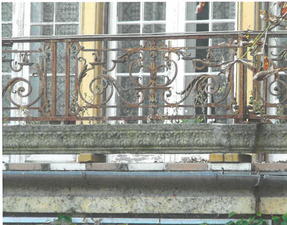
A terasz korlátja eredeti, furcsán megemelve; alul levélsorral díszített előregyártott műköpárkány, fölötte igen szép formálású, elegáns, barokkos, felújításra szoruló vasrács
