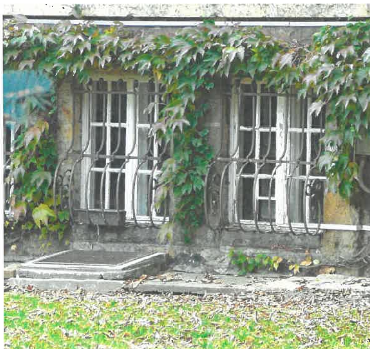
A terasz alatti ruszlikus homokkőburkolatú alagsori szint ablakai: bal oldalon az 1942-es átalakítás során nyitott pinceablak, jobb oldalon az eredeti pinceablakok (1942-ben házmesterlakássá alakított rész ablakai) egyszerű kosaras vasráccsal (ld. 15. old.)
