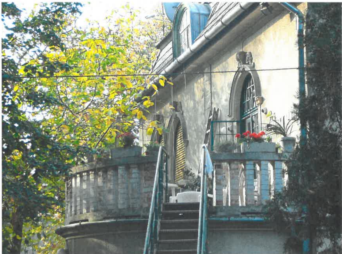
Az egykori télikert helyén ma nyitott terasz; korlátja nem eredeti, keskeny, sűrű téglapillérek, alattuk eredeti műkő vízkivezetős párkány, felette műkő könyöklőpárkány
