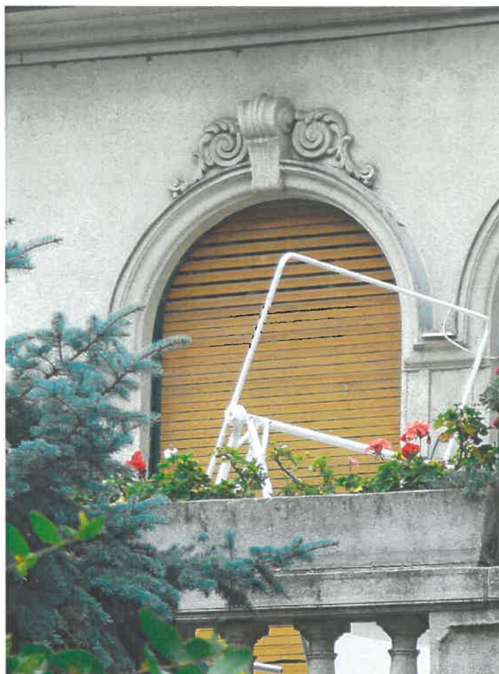
A magasföldszint utcai és két oldalhomlokzati félköríves záródású nyílásai vállmagasságtól induló, valutákkal díszített nagy zárókövekkel lezárt párkányszerű keretezésűek
