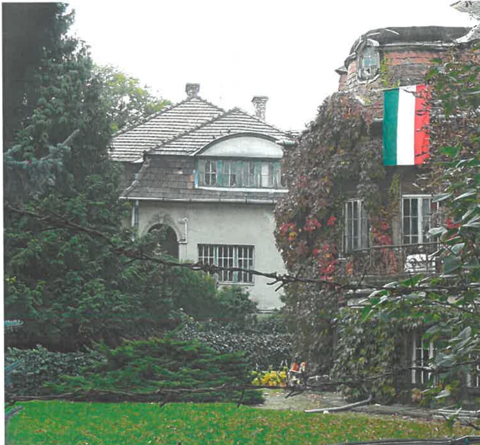
A jobboldali oldalhomlokzat szegmensívű oromzatú széles tető-, ill. lépcsőház-megvilágítója barokkosan ívelt sarkú ablakaival érdekes utcaképi elem
