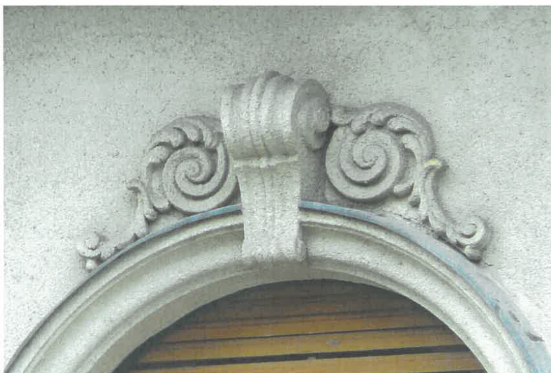
A magasföldszint utcai és két oldalhomlokzati félköríves záródású nyílásai vállmagasságtól induló, valutákkal díszített nagy zárókövekkel lezárt párkányszerű keretezésűek
