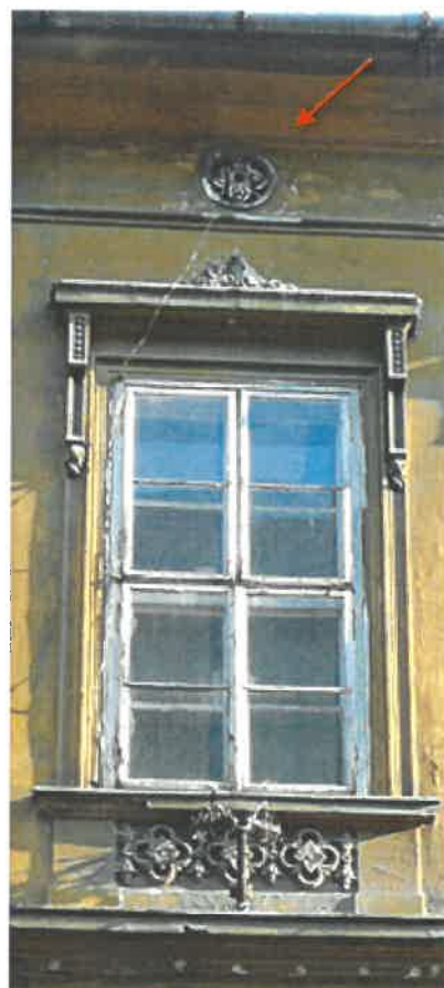
A főhomlokzatot főpárkányának frízét díszítő rozettasor a padlástér megvilágítását is szolgálja
