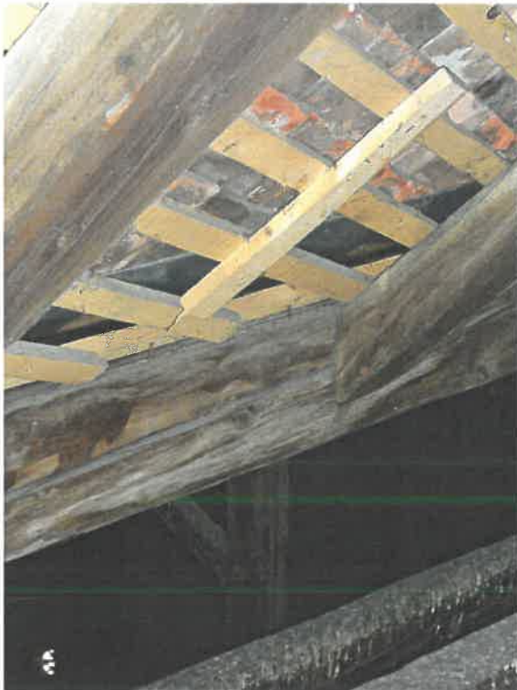
Szokásos fedélszék: kötőgerendákon álló ferdetámas oszlop könyökfákkal, fogópárral, talpszelemen, fiókváltók
