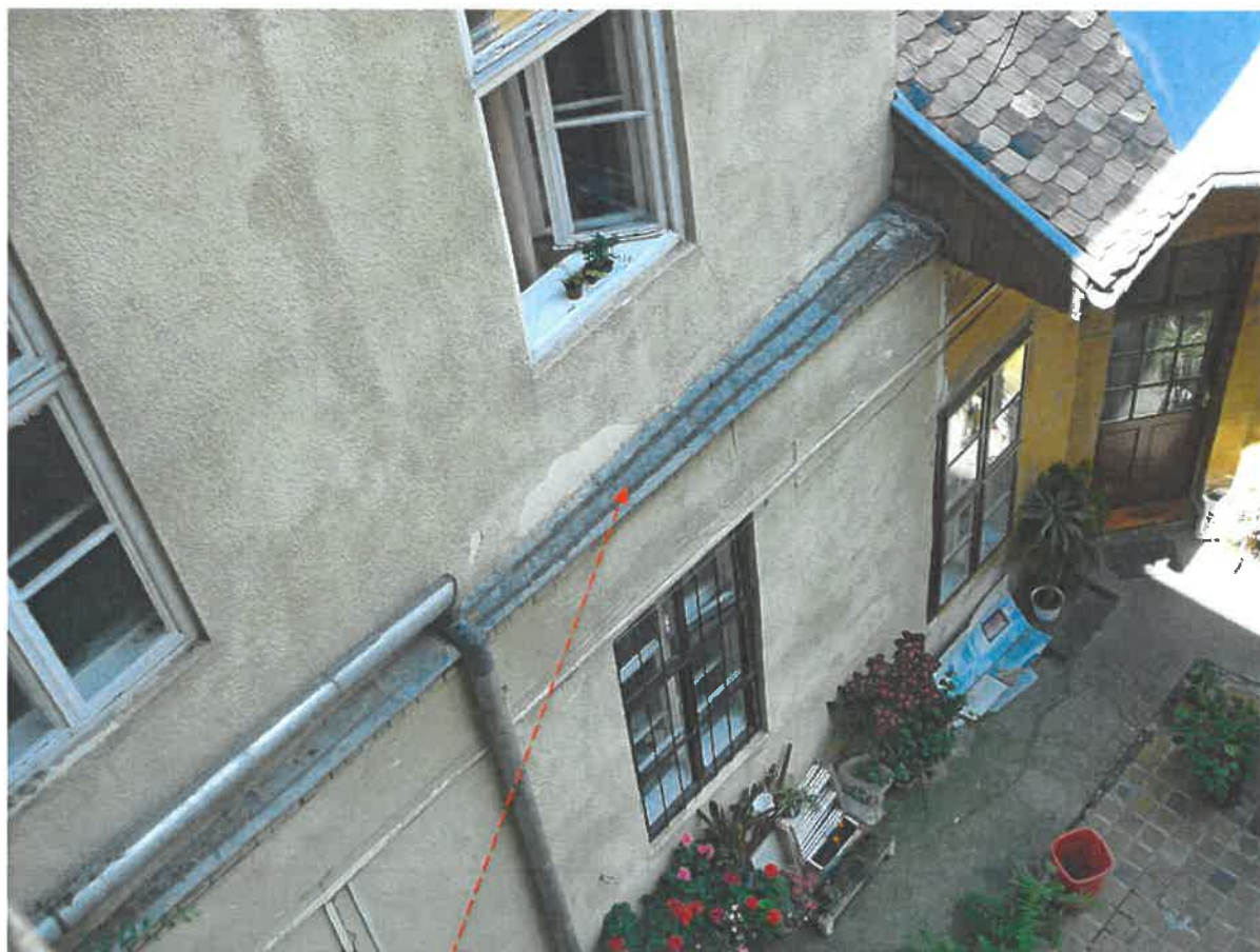
A Hattyú utcai ház jól leolvasható módon az 1861-ben épült Csalogány utcai épület emeletére épült rá (ezt mutatja a kis szögletérés a földszint és az emeletek falsíkja között)
