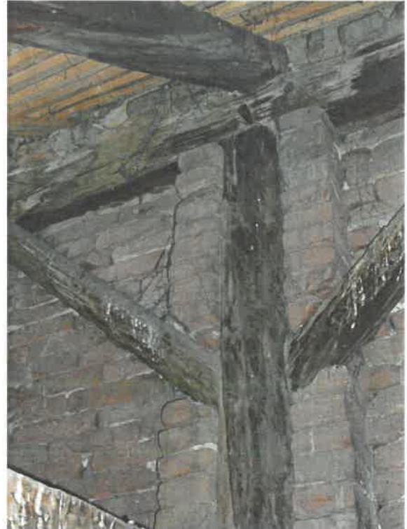
Szokásos fedélszék: kötőgerendákon álló ferdetámas oszlop könyökfákkal, fogópárral, talpszelemen, fiókváltók
