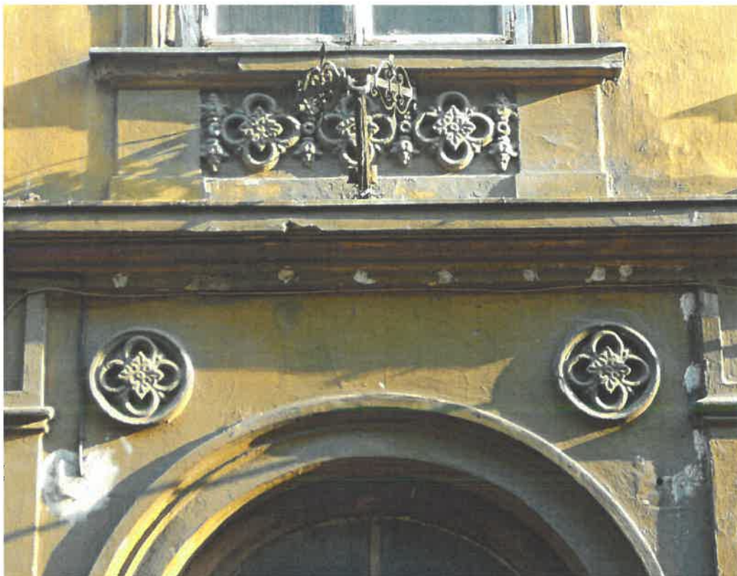
A bejárati kapu ívháromszögeiben a főpárkányon végigfutó rozetta-díszek; a középtengely emeleti ablaka alatt eredeti szép, kovácsoltvas zászlótartó
