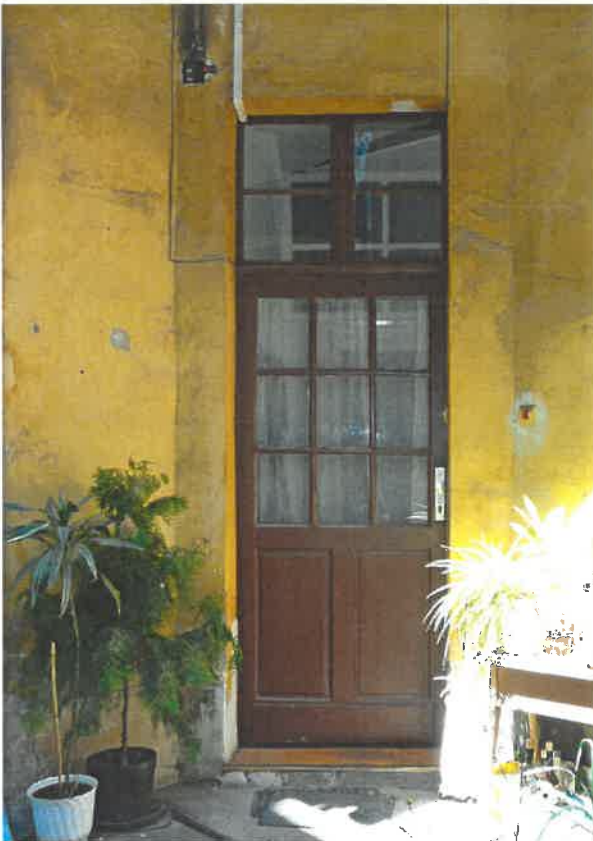
A lecsapott sarkokon az udvarból nyíló bejárati ajtók későbbiek: a baloldali az 1930-as, a jobboldali az 1970-80-as éveket idézi; a keskeny ablak eredete a mellette lévő szegmensíves nyílással együtt további kutatást igényel
