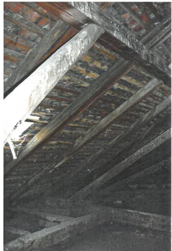
Szokásos fedélszék: kötőgerendákon álló ferdetámas oszlop könyökfákkal, fogópárral, talpszelemen, fiókváltók
