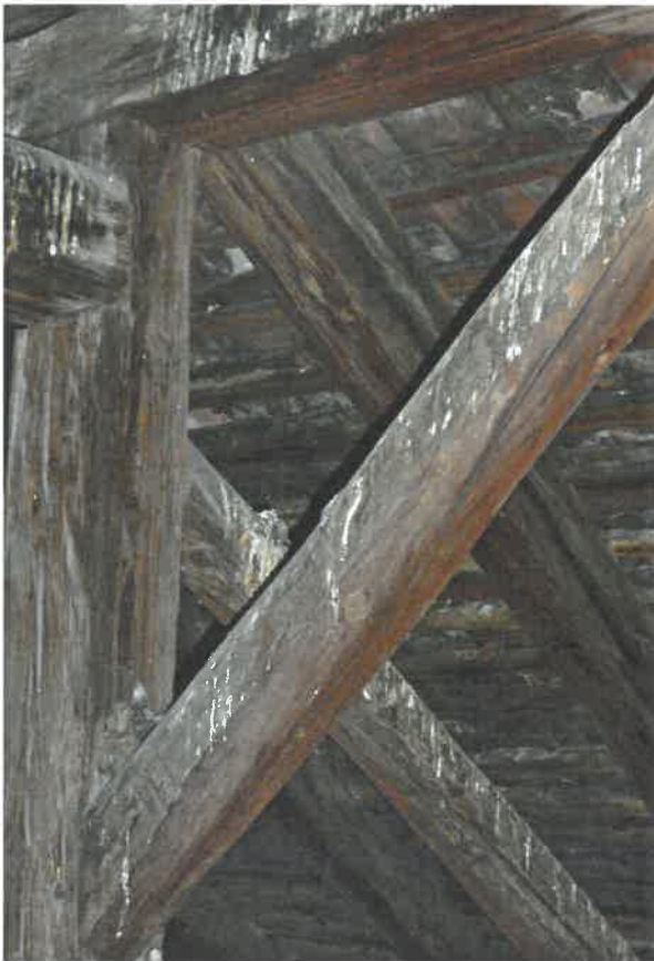
Szokásos fedélszék: kötőgerendákon álló ferdetámas oszlop könyökfákkal, fogópárral, talpszelemen, fiókváltók
