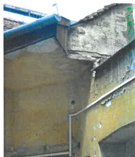
A cseréphéjalású tető a Hattyú u. 11. lépcsőházából
