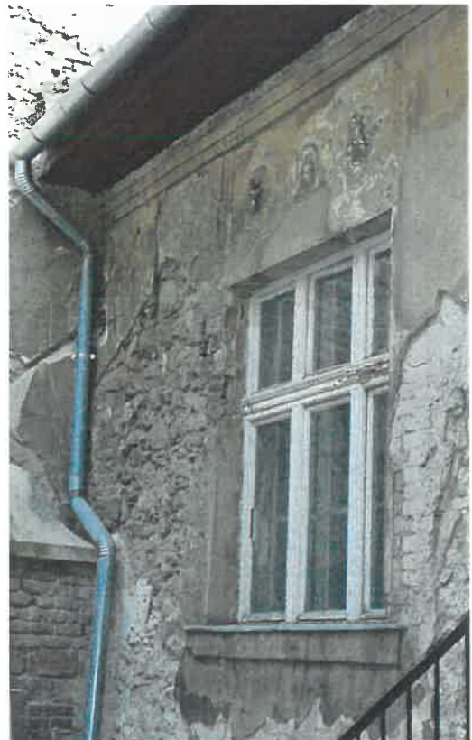
A régi udvari épület – valószínűleg az épület átépítésekor lecserélt - ablaka
