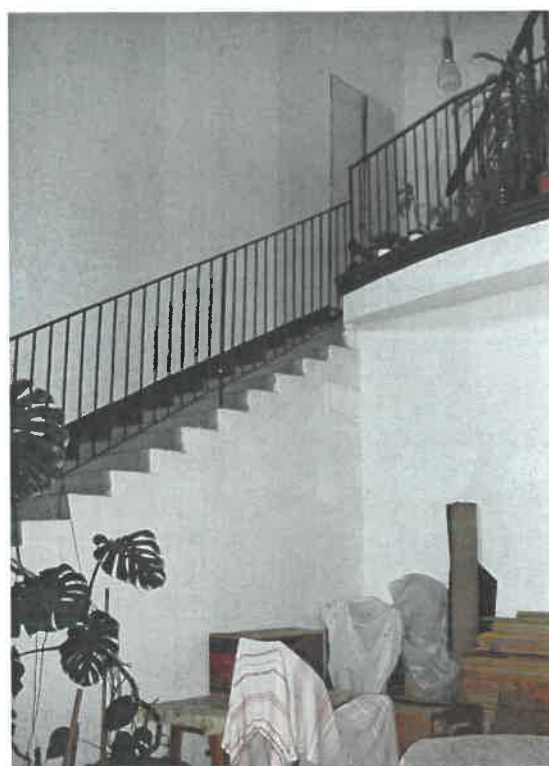
Az elpusztult falépcső helyett épített betonlépcső a hallban sematikus fém pálcakorláttal
