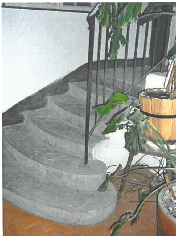
Az elpusztult falépcső helyett épített betonlépcső a hallban sematikus fém pálcakorláttal
