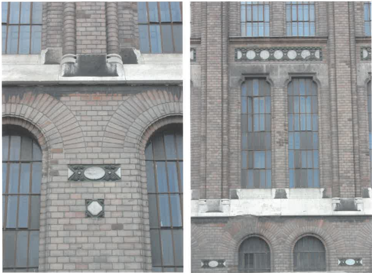
keleti raktárszárny, homlokzati részletek
