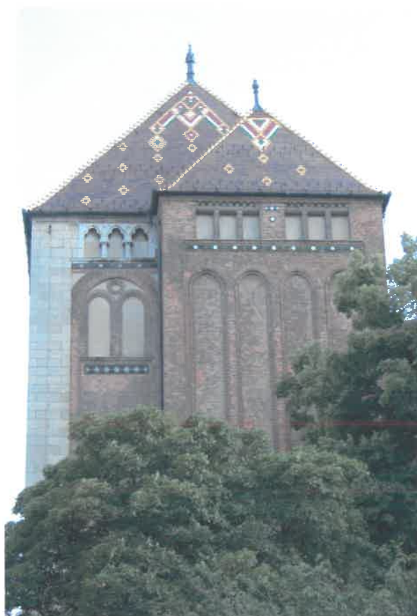
a keleti raktárszárny északi homlokzata
