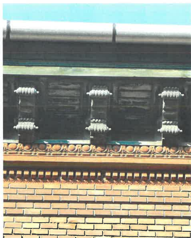
A sűrű fekvőkonzolokkal alátámasztott főpárkány, alatta tojássor, gyöngyfűzér, fogrovat
