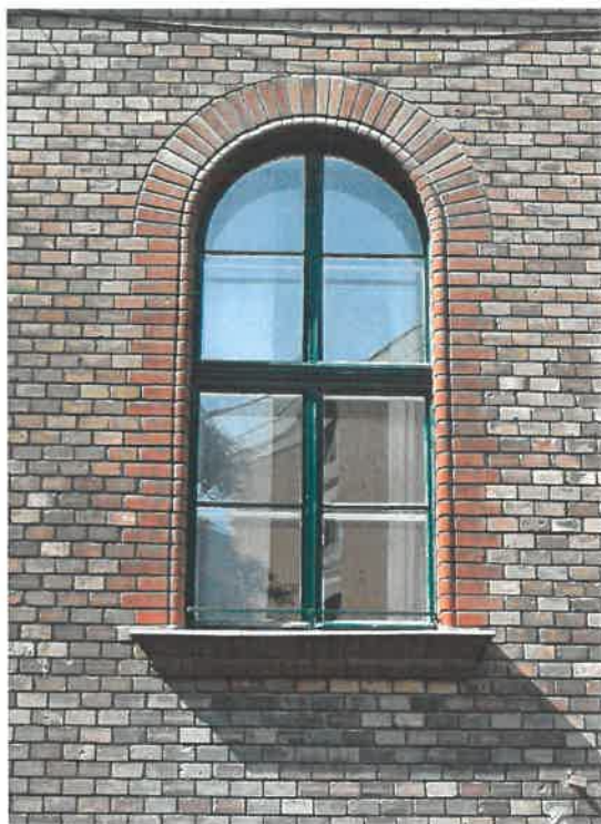
A földszint finom, hengerszerű díszkeretet adó idomtéglaával keretezett ablakai
