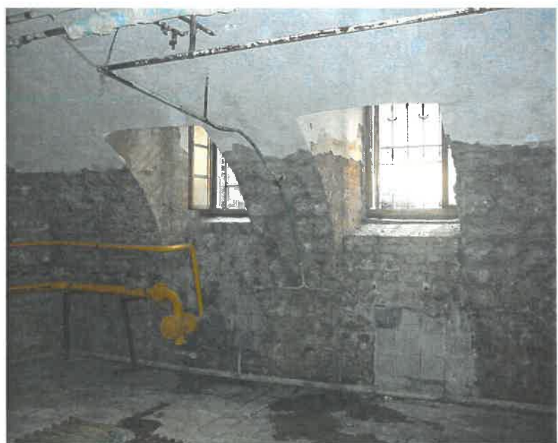
A pincelejárát és a dongaboltozatos pince állapota 2009. júniusában a nyári felújítás előtt
