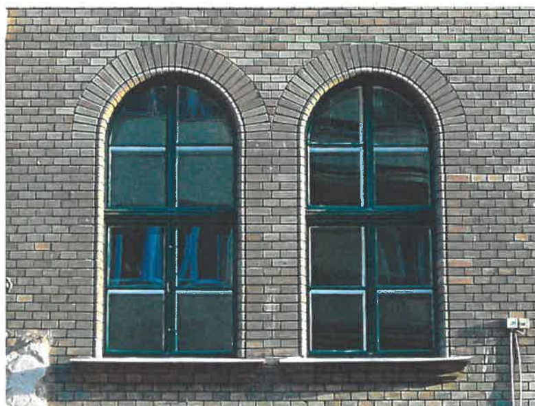
A főhomlokzat középrizalitjának hármas- és ikerablakai az emeleten és a földszinten
