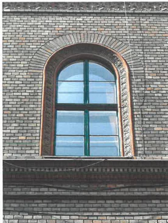
Az I. emelet ornamentális díszítésű kerámiaabetétes bélletű, sugaras téglalövvel zárt ablakai
