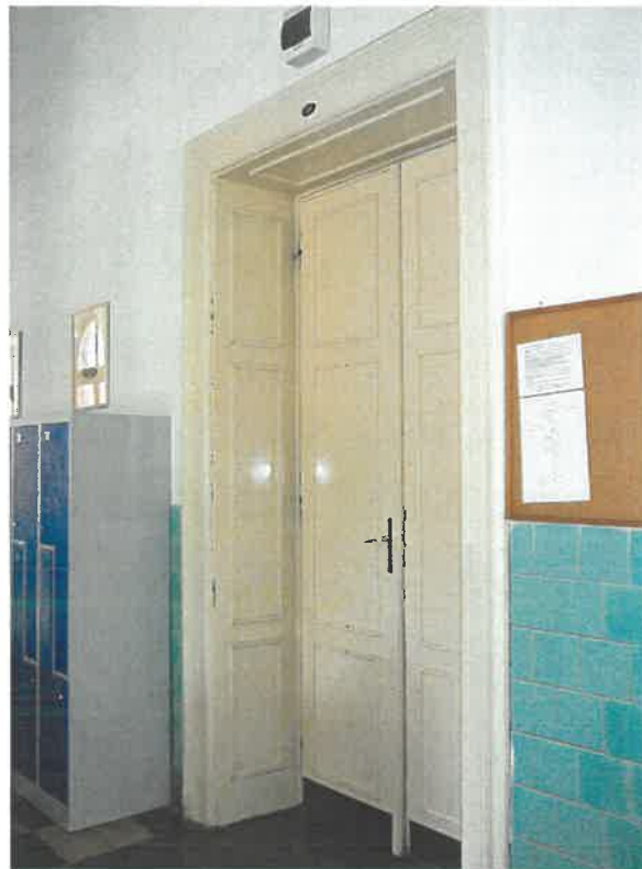
Eredeti táblázatos ajtók a vastag középfalban – némelyik felújításra szorul
