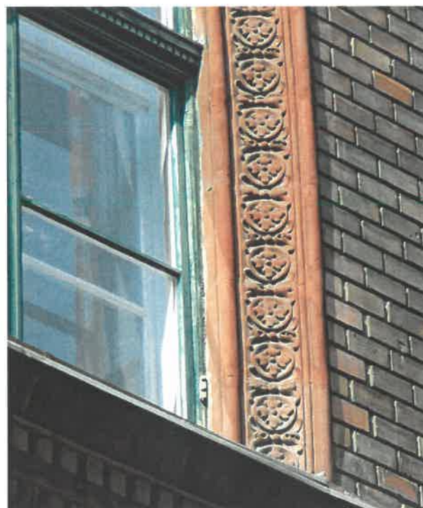
A széles, íves formálású terrakotta ablakbéllet-dísz az I. emeleti ablakokon
