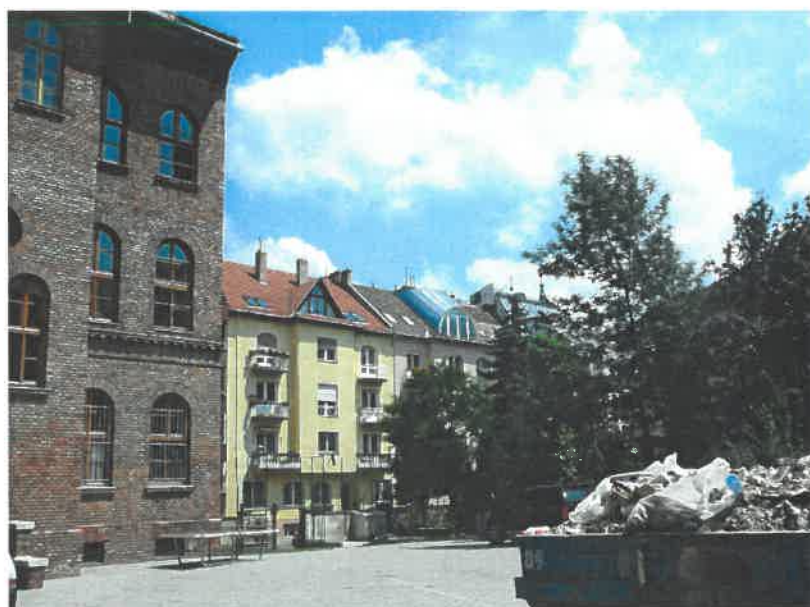
Az utcaiakkal közel azonos minőségben megépített udvari homlokzatok
