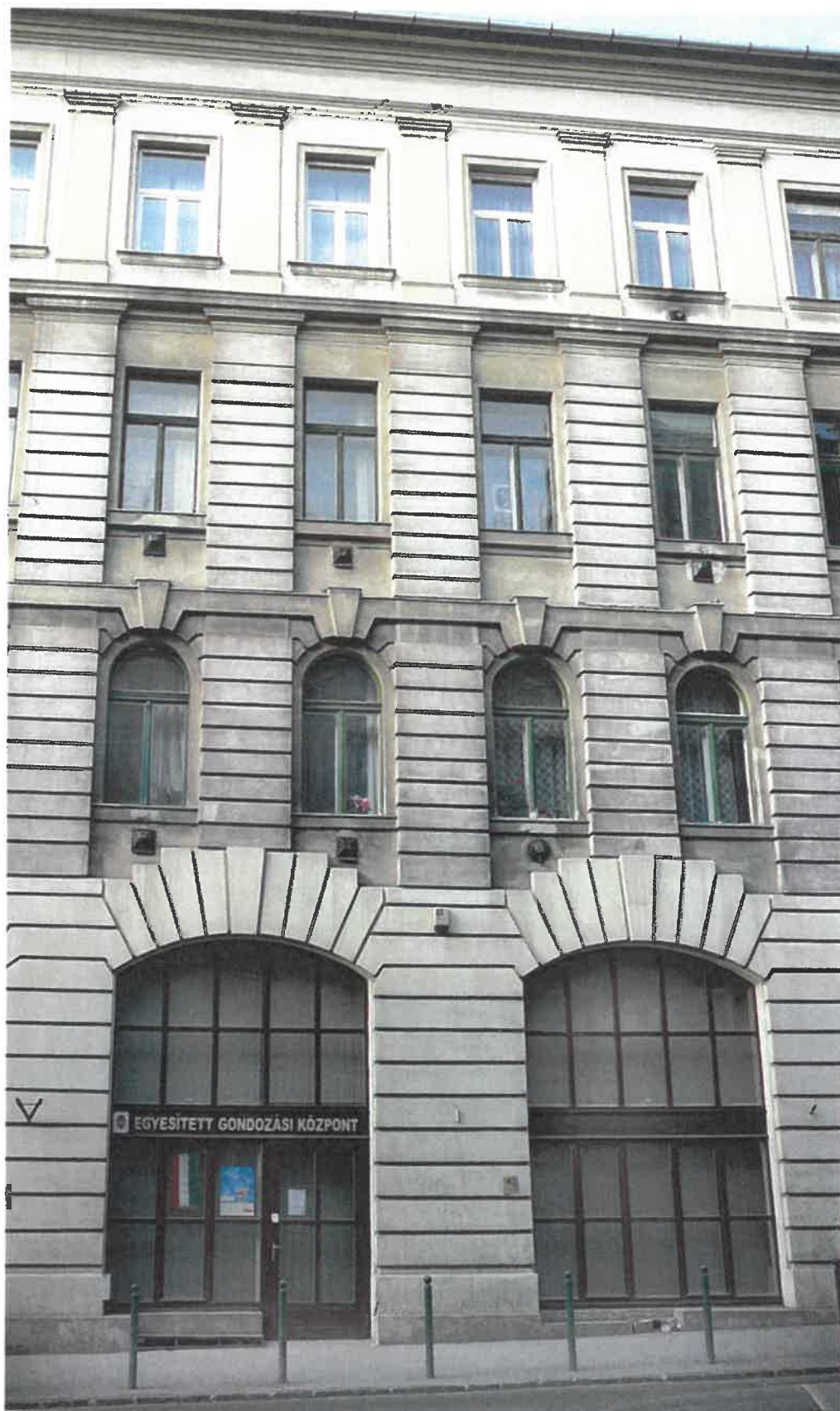
A nagy, két axist összefogó földszinti szegmensívű nyílások a szokatlanul felhúzott boltívkváderekkel friss szellemű tervezőre utalnak
