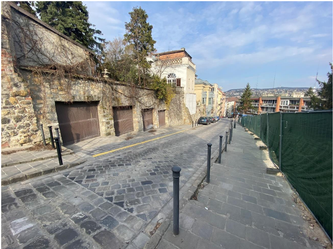
A Fiáth János utcai támfal garázsok (saját fotó – 2026.03.24.)
