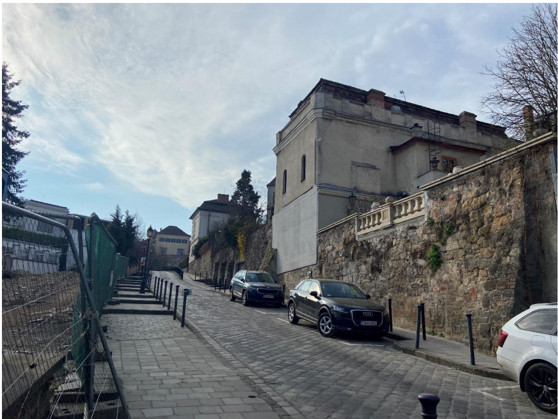
A Fiáth János utcai támfal és beépítés a Szabó Ilonka utca irányából (saját fotó – 2026.03.24.)
