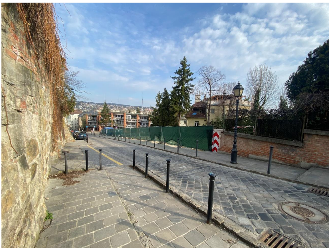
A 14044/1 hrsz. telek a Fiáth János utca felső szakaszáról (saját fotó - 2026.03.24.)
