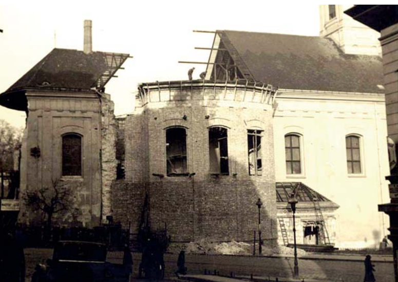
A kibővített templom az épülő új kereszthajóval
