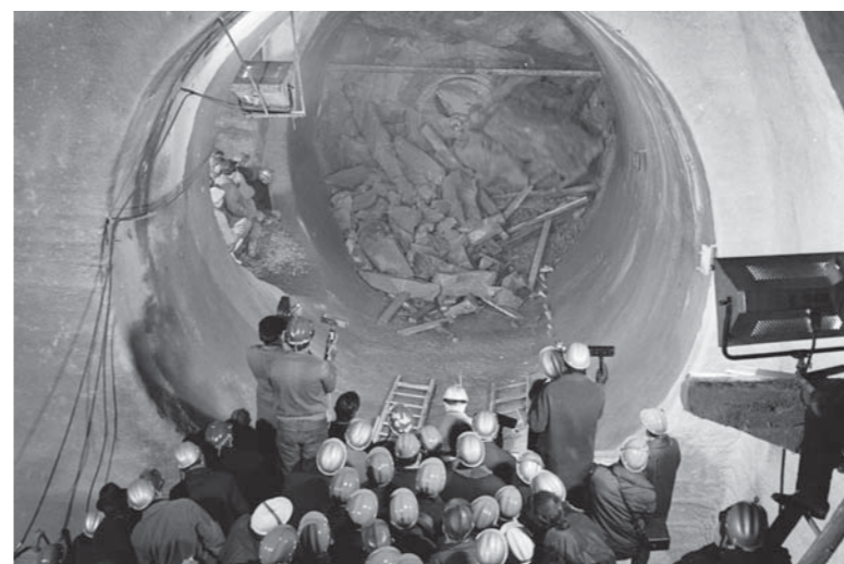
Metróalagút-építés a Batthyány tér és Széna tér között 1970-ben
