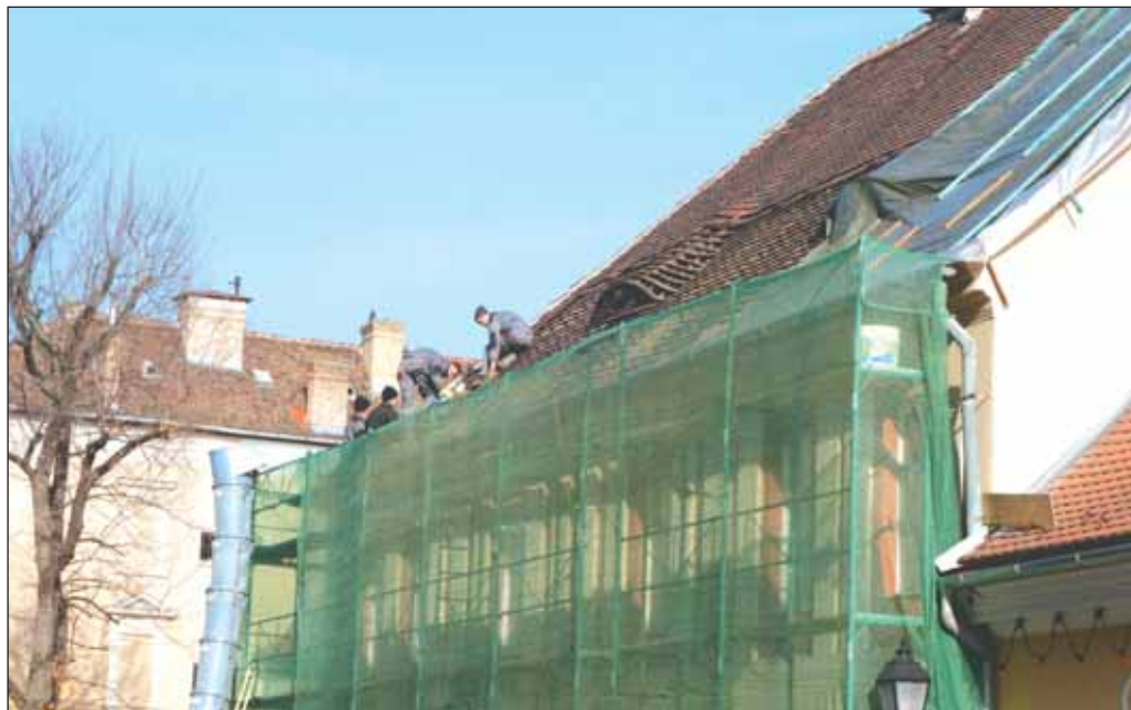
Országház utca 19. – Új tetőt kap a saroképület
