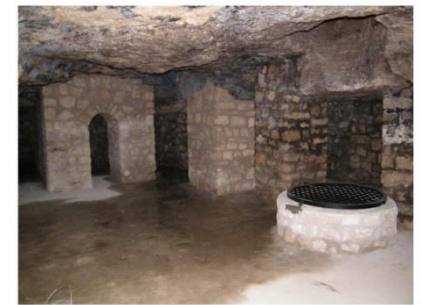
A megépített falazatok és a ráccsal lefedett kút
