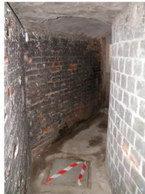
A betontéglafallal stabilizált folyosói szakasz
