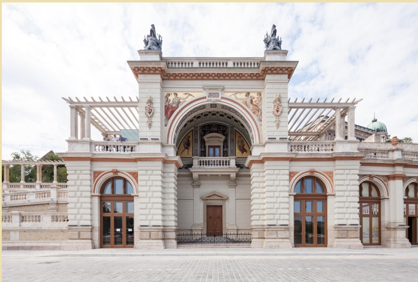
Várkert Bazár felújítás
