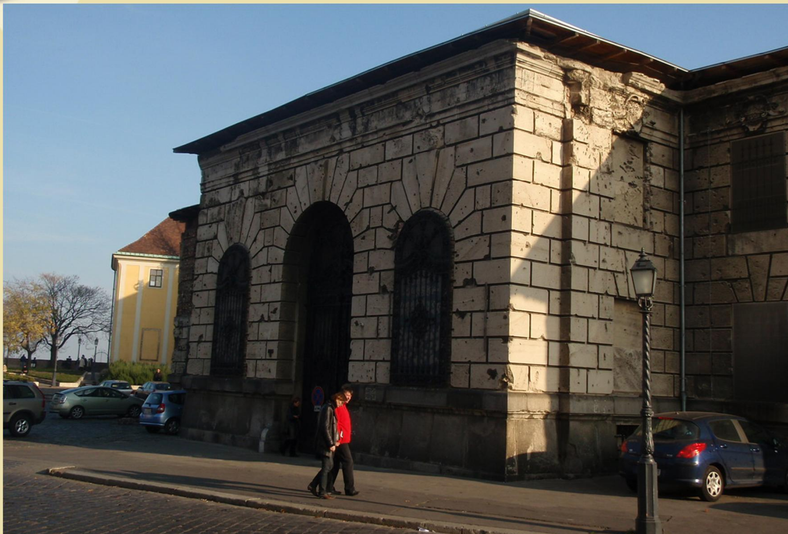
Dísz tér 17. felújítása
