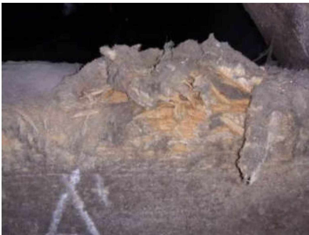
1. ábra Ázott szerkezet, rovarkárosodás a talpgerenda, attikagerenda környezetében
