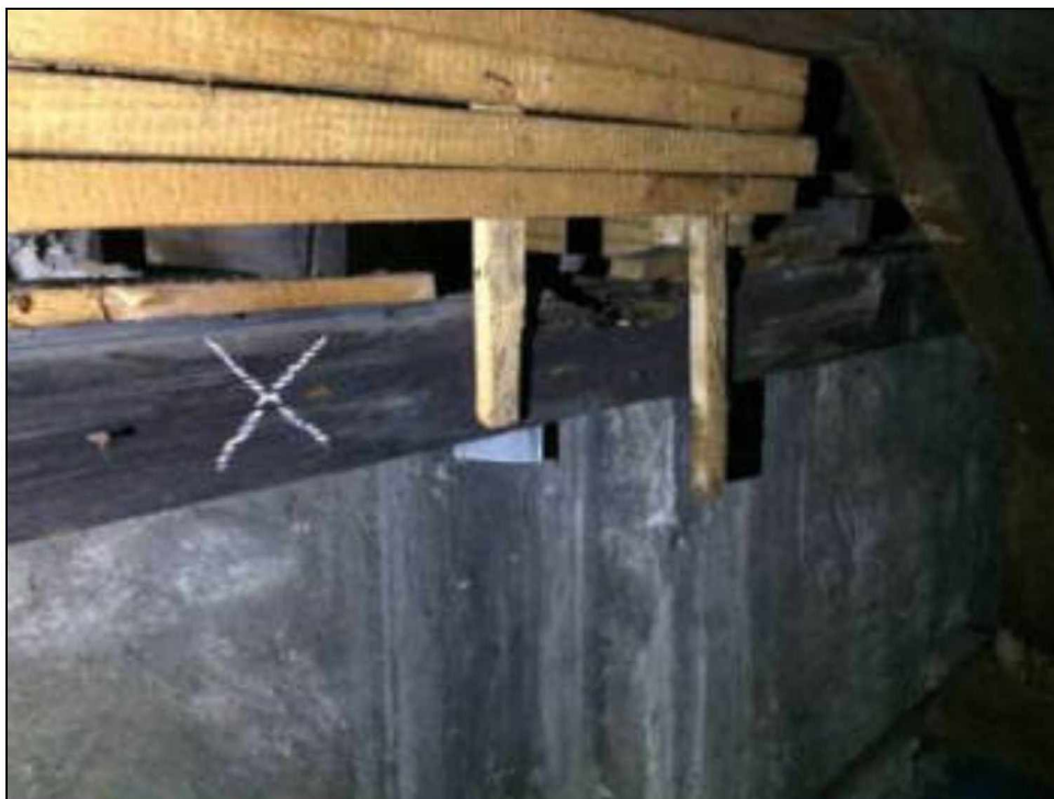
4. ábra Jelentős csomóponti tönkremenetel a 12. főállásban
