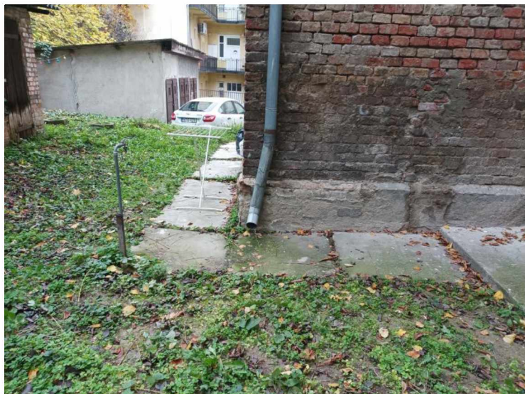
1. - 2. fotó: az esővizet jelenleg a házfal mellé kivezető ereszcsontrák, melyek vize a pályázat nyomán esővízgyűjtő tartályba fog kerülni
